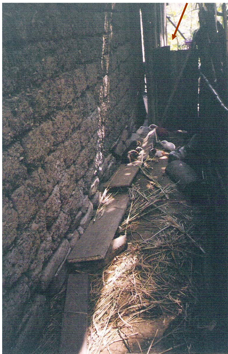
Figura 7. Presencia de cobayos alrededor de la vivienda y en constante ingreso hacia el interior de la misma (cocina)
