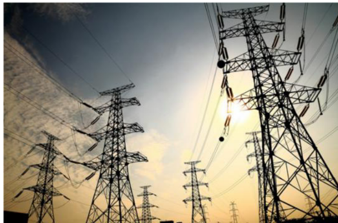
FIGURA 1.2: Torres autosoportada galvanizada – electricidad
