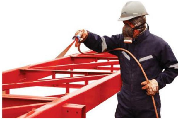
FIGURA 3.2: Estructura metálica en proceso de pintado.
