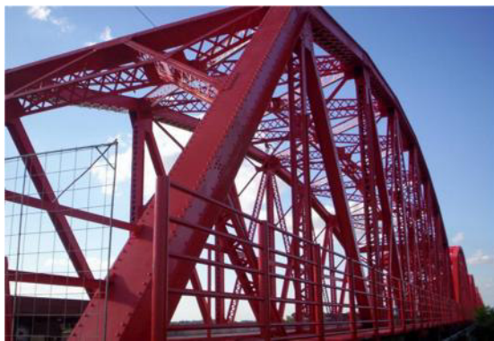
FIGURA 4.1: Estructura de puente con sistema dúplex, galvanizado y pintado.
