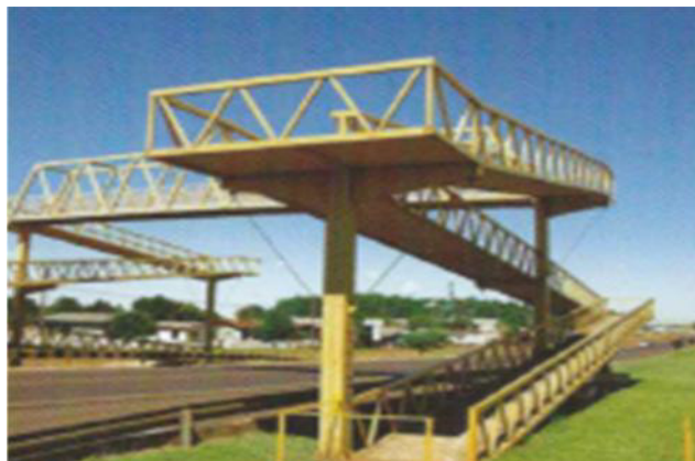
FIGURA 3.1: Escaleras peatonal con acabado en pintura poliuretano.
