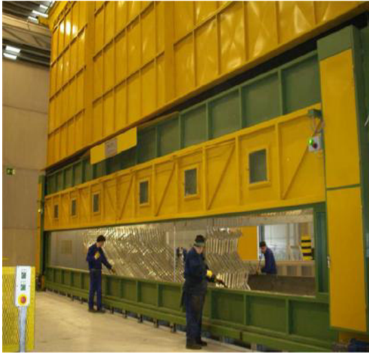
Sistema de extracción de vapores.
