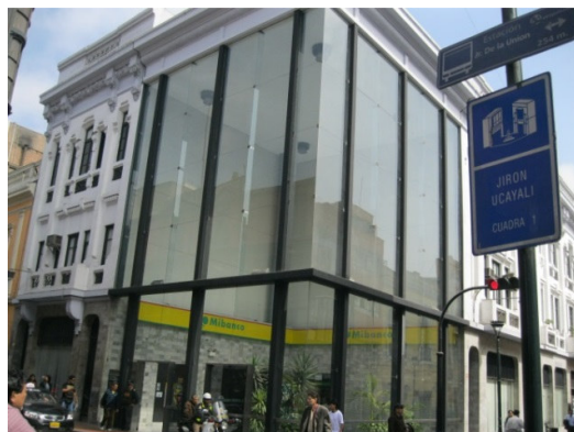
Foto 14: Foto actual de la antigua sede del antiguo Banco Mercantil. 192
