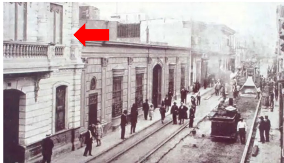
Foto 12: Calle de Pando en 1924. 159
