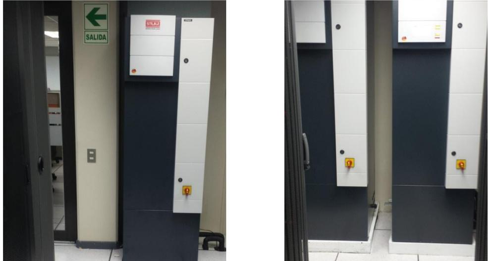
Figura 15. Aire Acondicionado de Precisión Stulz recientemente instalado
