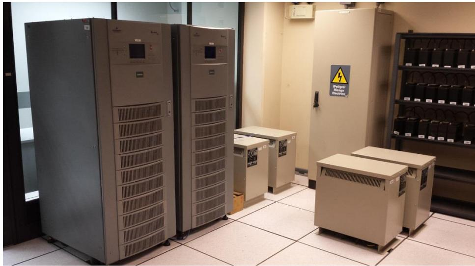
Figura 7. UPS Emerson y sus transformadores
