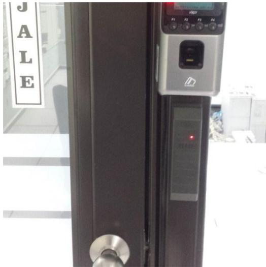
Figura 16. Lector de huella digital y de tarjeta magnética de la sala de servidores
