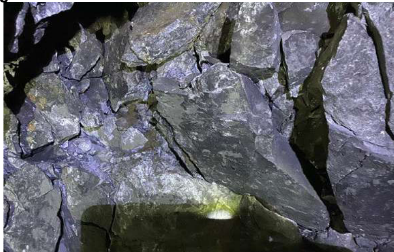
Figura 29. Pilares estresados en SLC - Nv. 1120 Piso 11.
