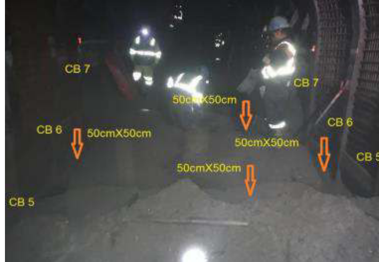
Figura 99. Dimensiones para coloca estructura de concreto.
