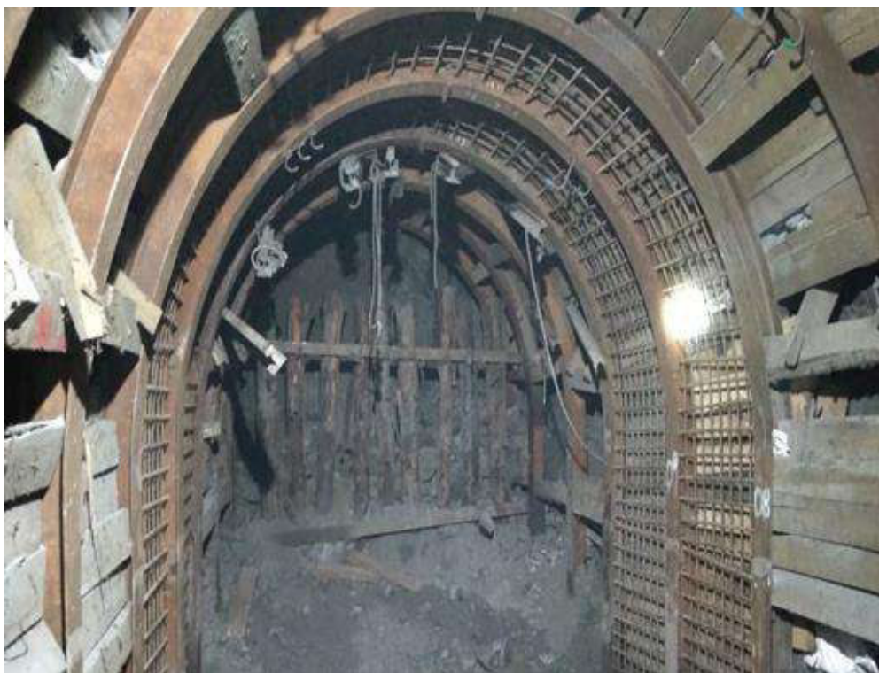
Figura 102. Estructura y enmallado del Arco Peruano.
