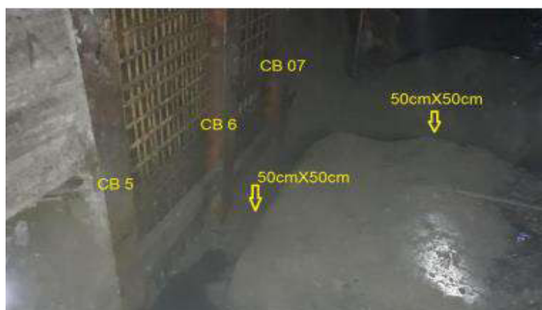
Figura 98. Excavación de 50cm x 50cm.
