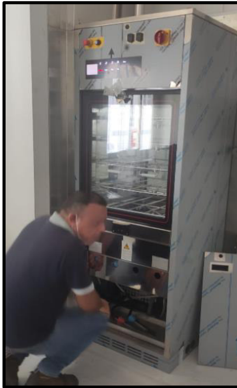
Figura 58: Verificación de estado físico – Tiva10 2V. Fuente: Propia
