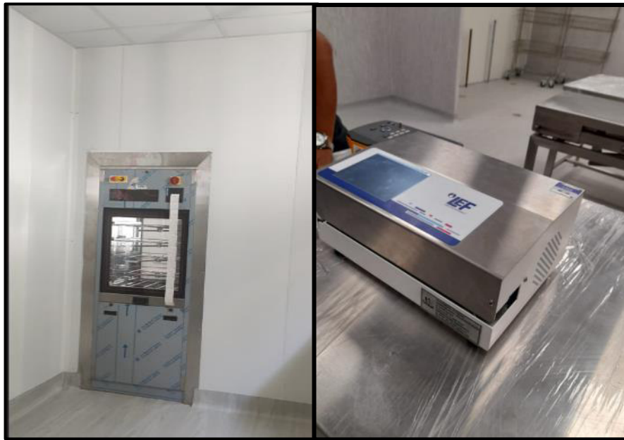
Figura 52: Instalación del Lavador (lado descarga) y Sellador de mangas – Área Azul. Fuente: Propia
