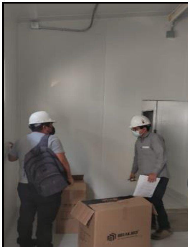
Figura 20: Área de la Planta de tratamiento de agua. Fuente: propia
