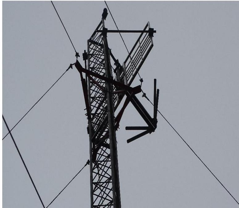
**Figura 11.** Antena de Dos Dipolos Cruzados en polarización circular
