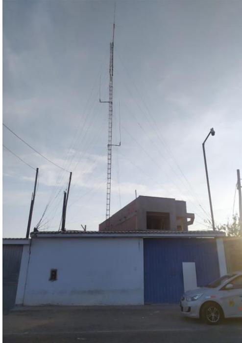
**Figura 8.** Antena monopolo con plano a tierra en una estación de radio
