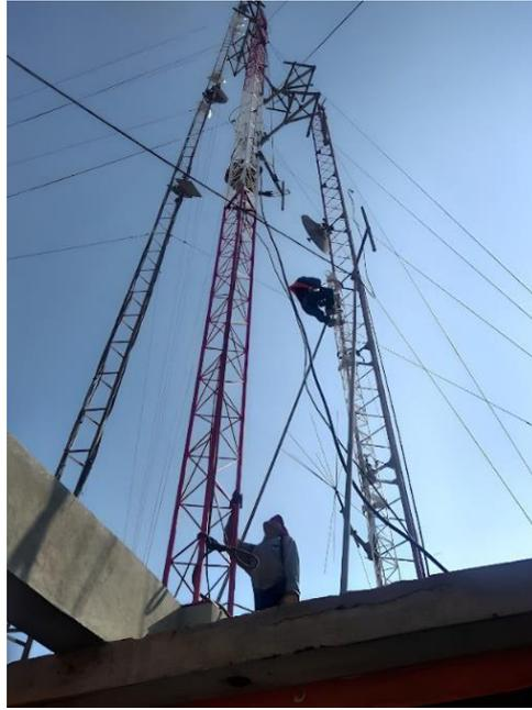
**Figura 20. Sistema irradiante del bloqueador instalado**
