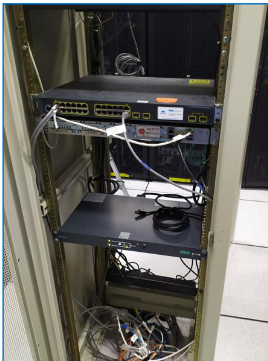
Figura 52. Situación de equipos antes del traslado Fuente: Elaboración Propia
