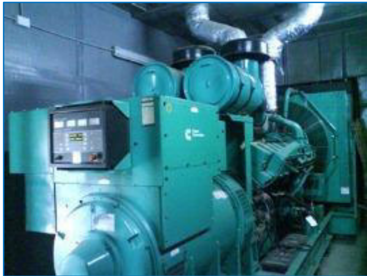
Figura 13. Grupo Electrónico Principal Fuente: Especificaciones técnicas DC Lince
