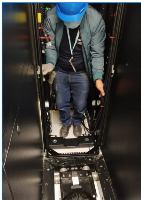
Figura 56. Instalación de equipos y gabinetes en DC Lince Fuente: Elaboración Propia
