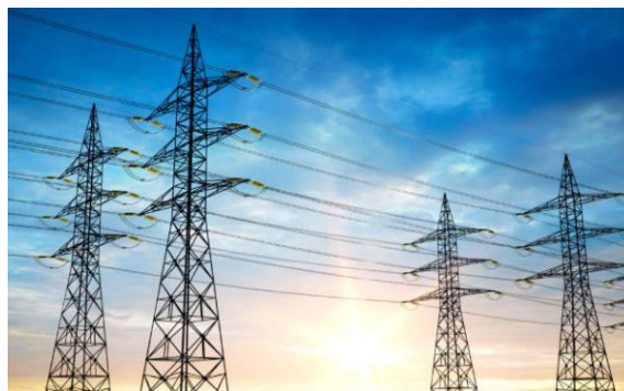
Figura 5: Líneas de Transmisión de energía Eléctrica. Fuente: Google Imágenes
