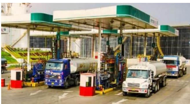
Figura 2: Planta de abastecimiento de combustibles
