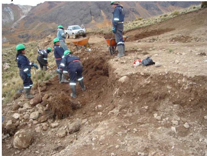
Figura 16: Trabajos de remediación en la zona de Tunshuruco
