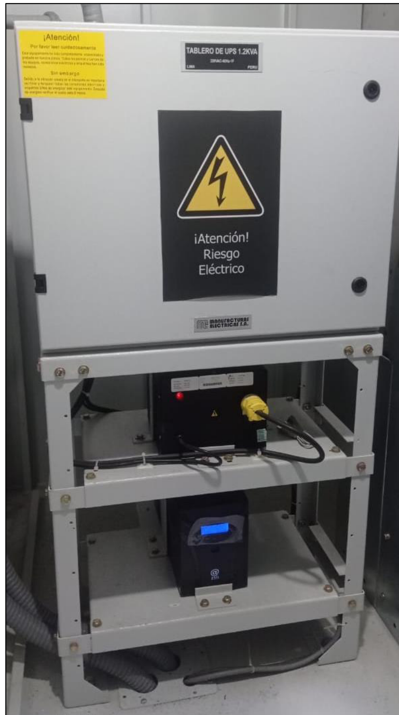
Figura 11: Instalación de sistema de tensión auxiliar estabilizada. Fuente: Elaboración Propia.
