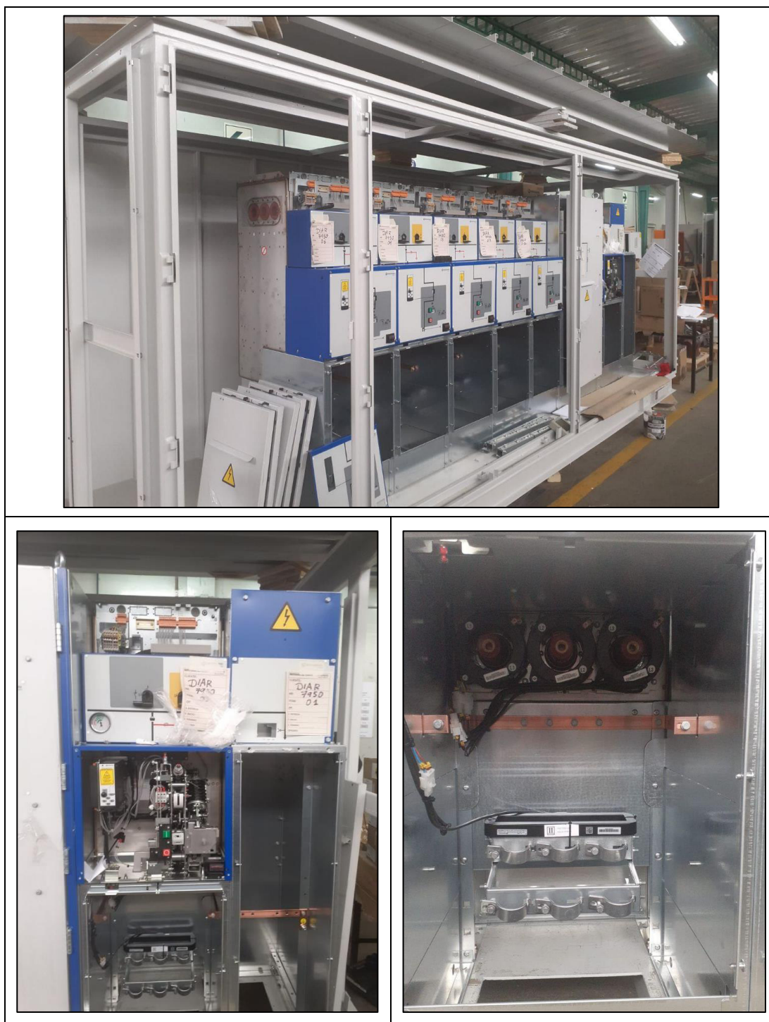
Figura 16: Supervisión del montaje de las Celdas GIS en la Instalaciones de MANELSA. Fuente: Elaboración propia.
