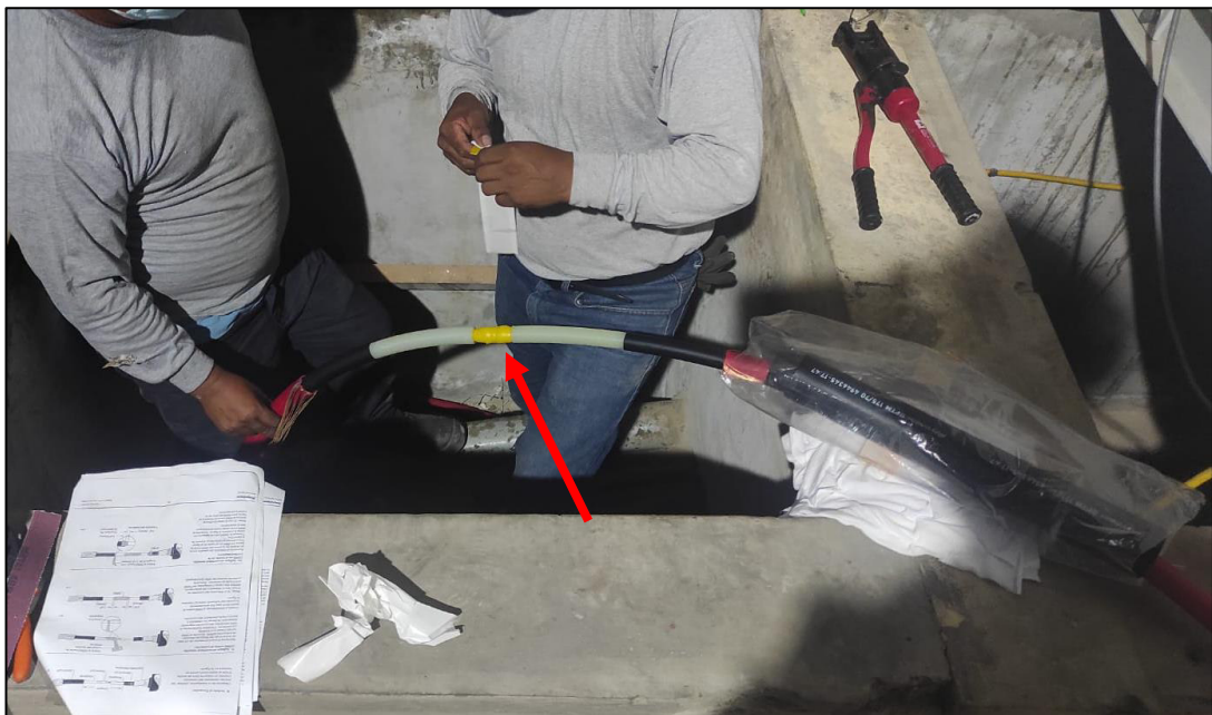
Figura 9: Ejecución de empalme tipo recto. Fuente: Elaboración Propia.
