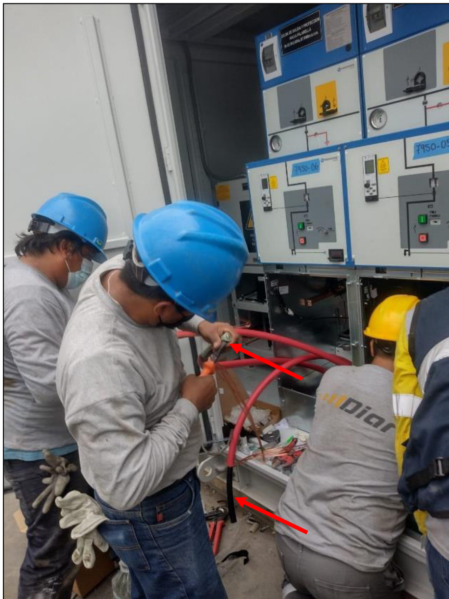
Figura 8: Ejecución de Terminación tipo codo. Fuente: Elaboración Propia.
