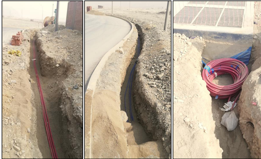
Figura 19: Tendido de conductores de media tensión. Fuente: Elaboración propia.
