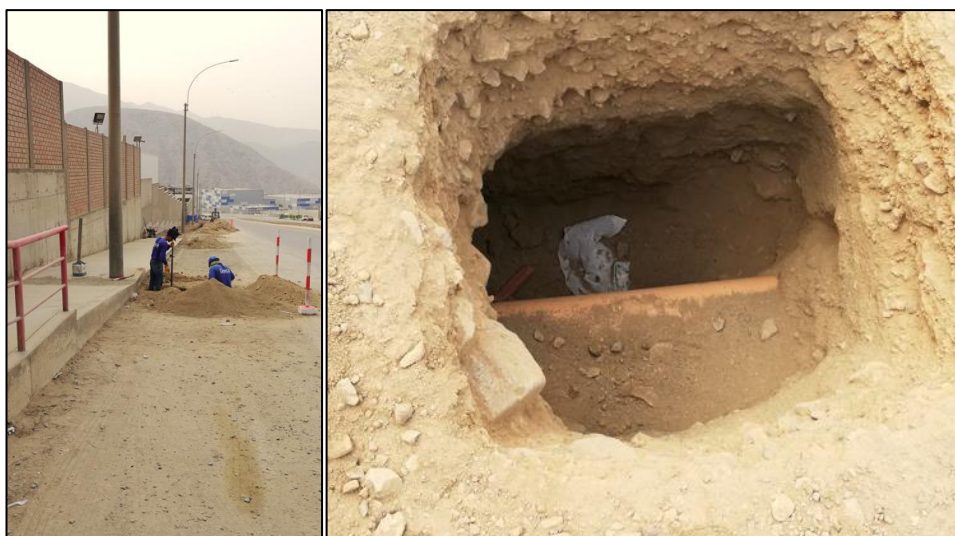
Figura 16: Calicatas encontrándose interferencias de tubería de Desagüe. Fuente: Elaboración propia.
