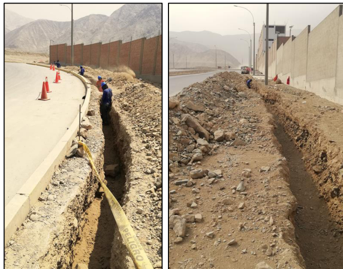
Figura 18: Excavación de zanja de red subterránea externa. Fuente: Elaboración propia.
