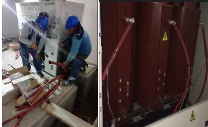
Figura 21: Terminación tipo Raychem. Fuente: Elaboración propia.
