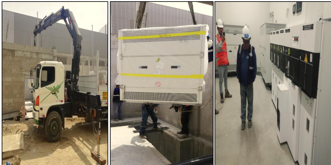
Figura 20: Izaje y Montaje de Celdas y transformador de la subestación N°1 y N°2. Fuente: Elaboración propia.
