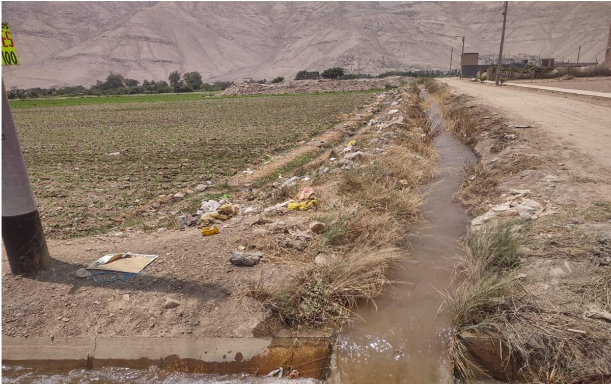
Imagen 8: Deterioro y contaminación de infraestructura agrícola, Chocas (2022). Foto: El autor.
