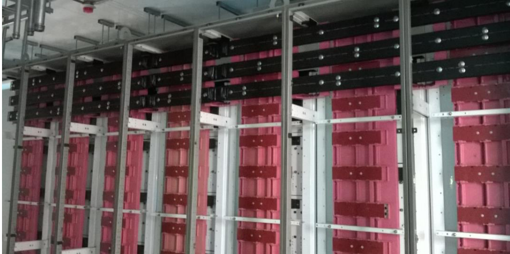
Figura N° 4.11 Disposición de CCM – Sistema de Barras
