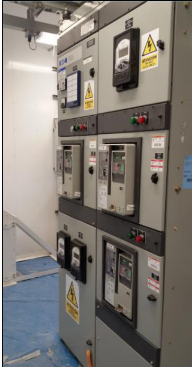
Figura N° 4.13 Switchgear Metal Enclosed BT Integrado
