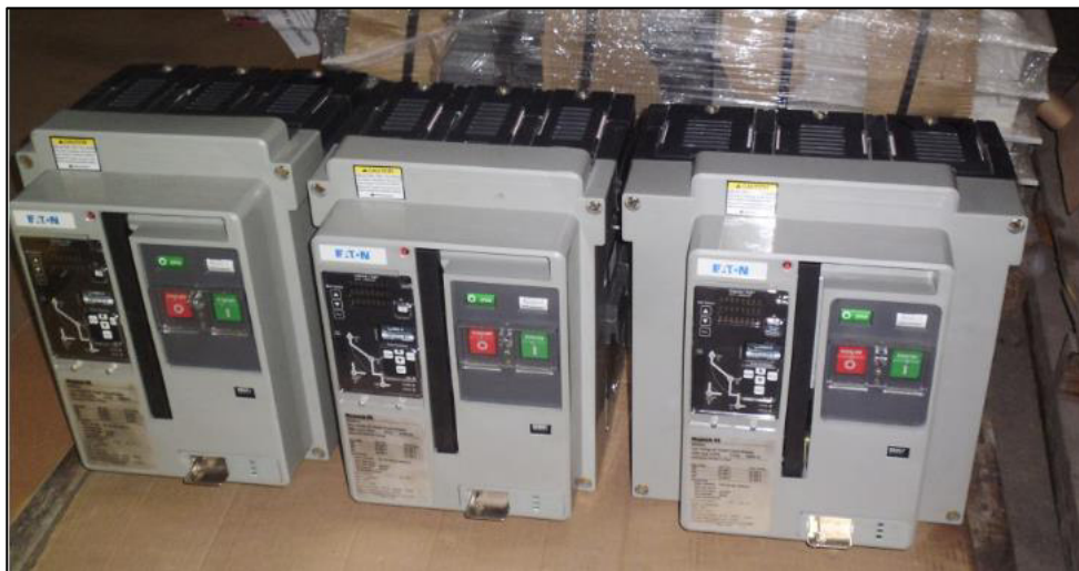
Figura N° 4.6 Montaje de Interruptores Magnum (Eaton)
