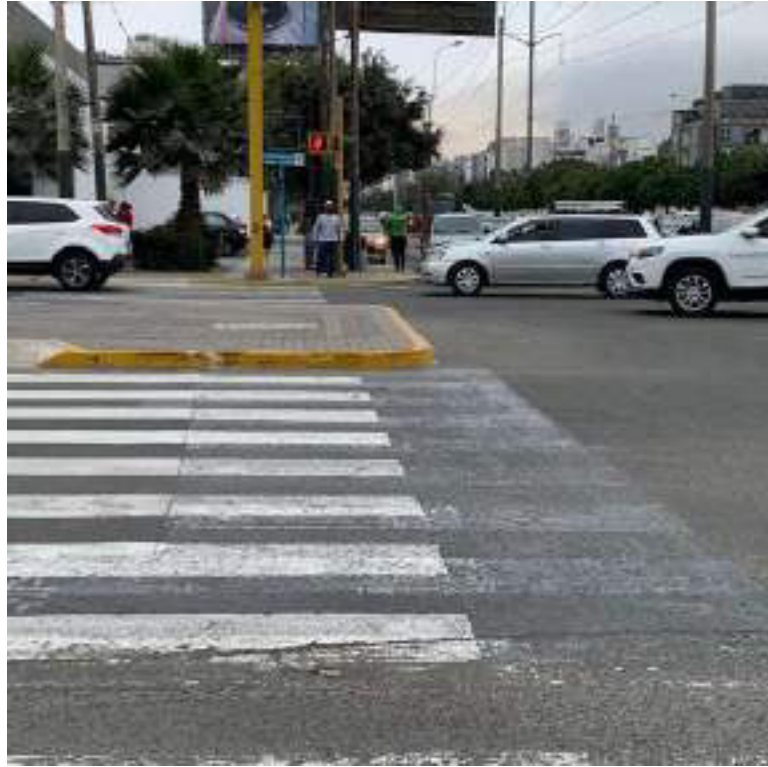
Figura 53. Paso peatonal Av. Velasco Astete N – S, antes de la intersección
