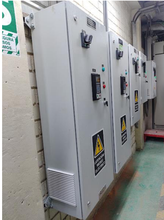
Figura 17. Montaje de Tableros Eléctricos
