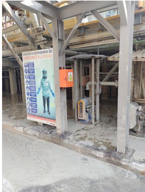
Figura 21. Montaje de caja botonera
