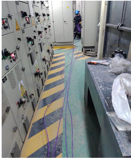
Figura 16. Tendido de cable ethernet
