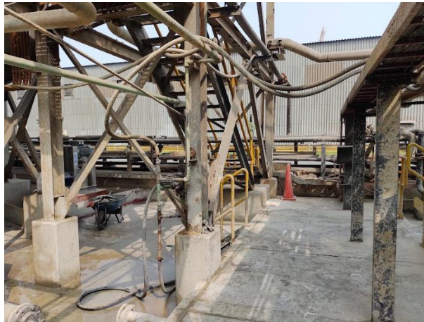
Figura 10. Inspección Inicial Flotación. Fuente: Elaboración Propia
