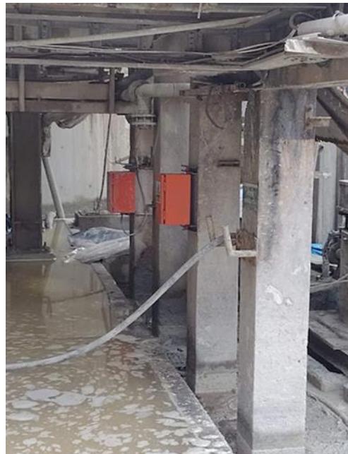
Figura 20. Montaje de caja botonera
