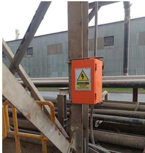
Figura 19. Montaje de caja botonera
