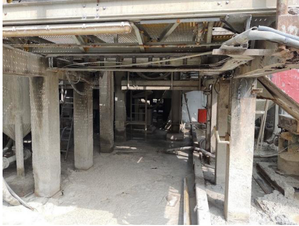
Figura 9. Inspección Inicial Flotación. Fuente: Elaboración Propia
