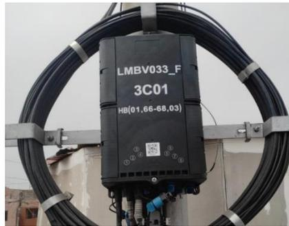
*Figura 29: Rotulación de Hub Box 1C01. Fuente: CNSIC*
