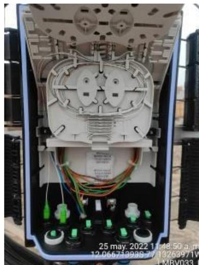
*Figura 27:* Bandeja de empalmes Hub Box 1C01. Fuente: CNSIC
