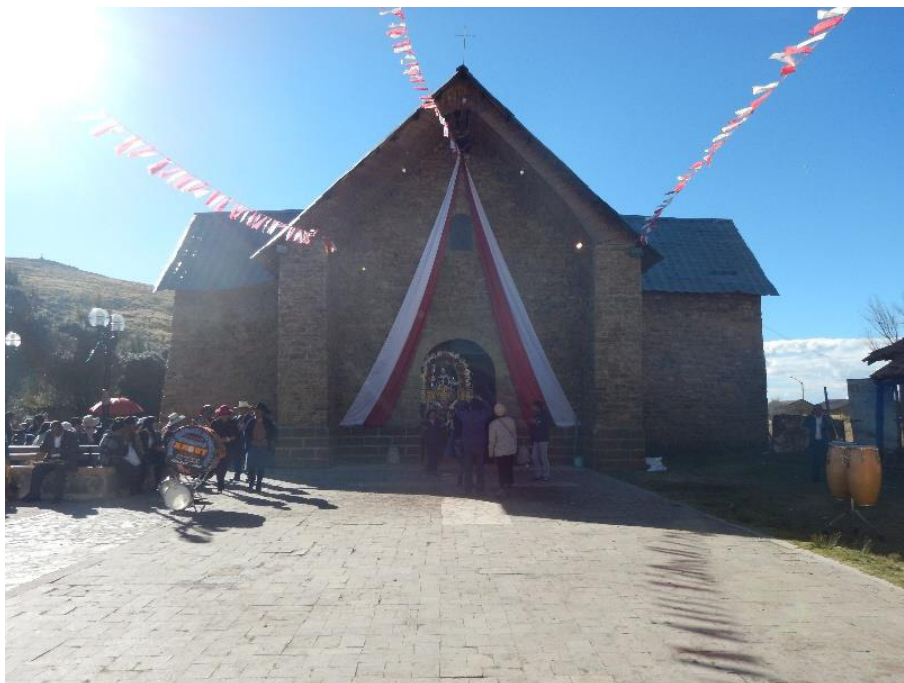
Fig. 14. Vista de la iglesia de Óndores. (Fuente: Archivo personal).
