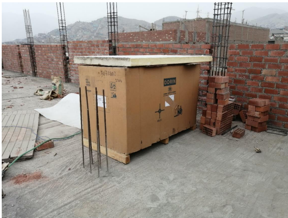
Gráfica A02 y 03 : Imagen de la unidad compresora instalada
