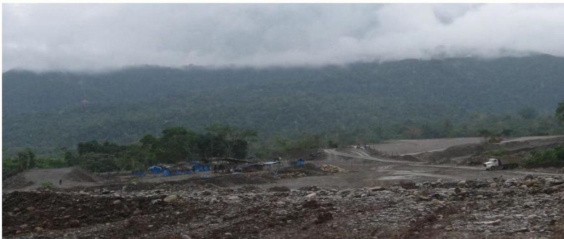
Figura 3. Campamento minero informal y volquete operando en las proximidades de la carretera Interoceánica en San Gabán - Carabaya. Fuente: Evaluación del Tramo 4 del eje vial Interoceánica Sur (2009).
