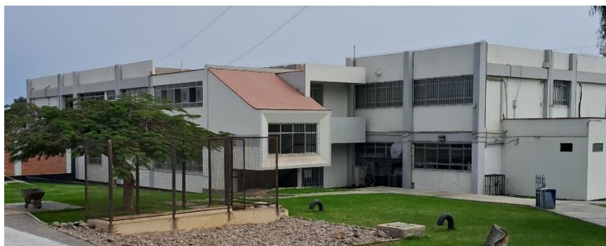
Figura 5 Edificio donde se ubica el área de Entomología Médica del Instituto de Medicina Tropical "Daniel Alcides Carrión" – UNMSM. Fuente: Elaboración propia
