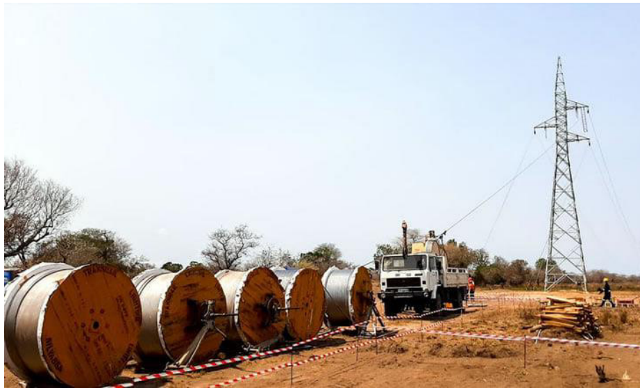
Figura 12 Mantenimiento de Línea de Transmisión Fuente. Club Mozambique, 2020 ( https://clubofmozambique.com/ )
