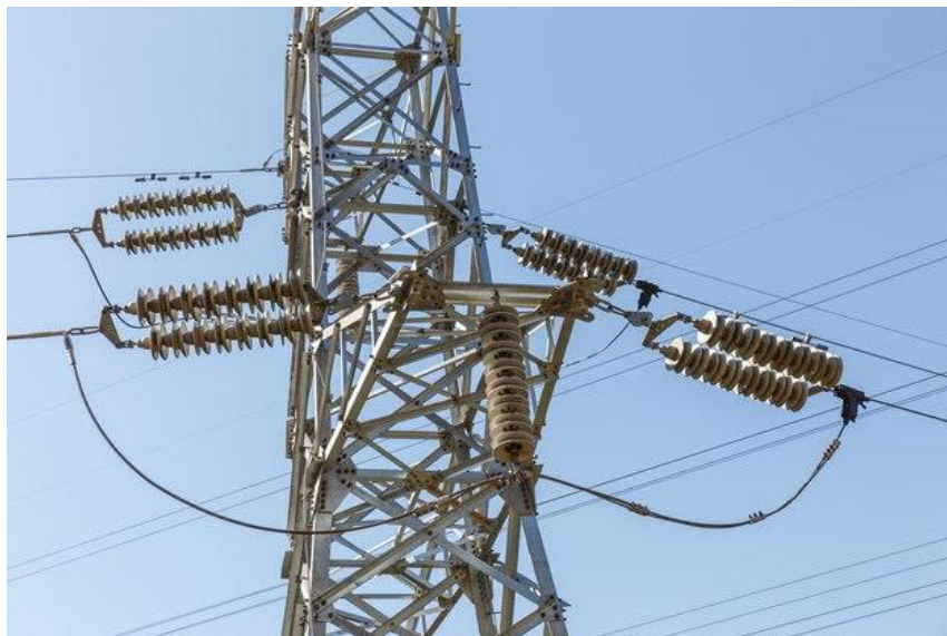
Figura 10 Detalle de Elementos en Torre de Alta Tensión Fuente. ISTOCK , 2019 ( https://www.istockphoto.com/ )
