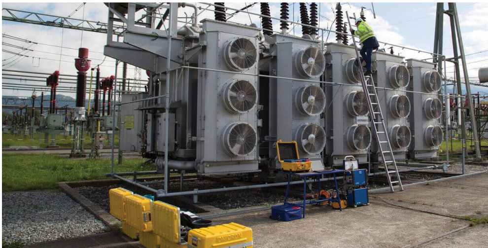
Figura 14 Mantenimiento de un Transformador de Potencia Fuente. OMICRON, 2017 ( https://www.omicronenergy.com/ )
