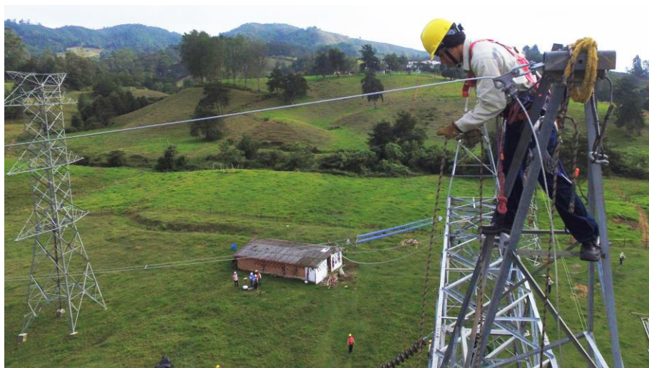
Figura 13 Especialista Liniero en Torre de Alta Tensión Fuente. Boletín ISA, 2016 ( https://www.isaintercolombia.com/ )
