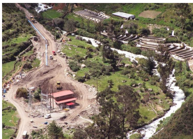
Foto 37. Nueva Central Hidroeléctrica II de Rapaz, en la margen derecha del río Yuraqyacu. Vista desde el pueblo de Rapaz (Foto: VFH)
