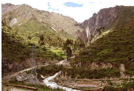
Foto 40. Torres de transmisión de la energía generada en la nueva Central Hidroeléctrica de Rapaz, sobre la margen derecha del río Checras. Al fondo aún se puede ver el estrecho de Punguyuq (Foto: VFH)
