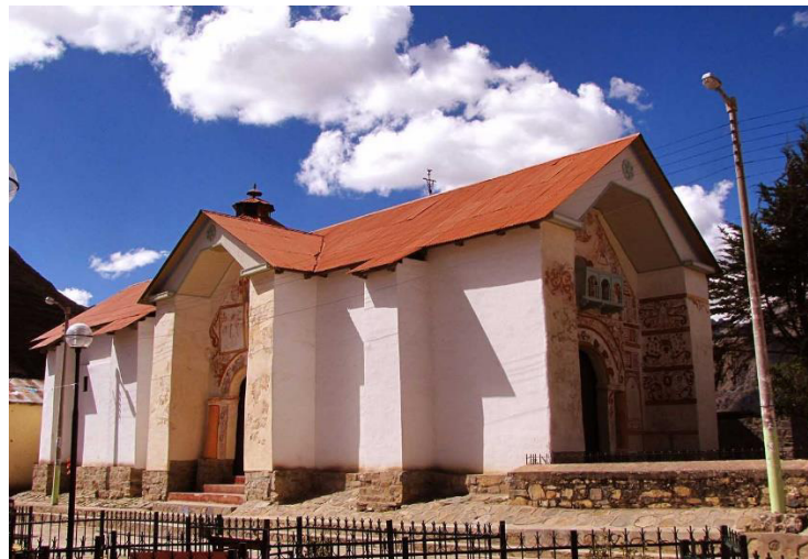
Foto 10. Iglesia colonial de Rapaz después de su restauración (Foto: VFH)
