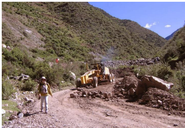
Foto 41. Mantenimiento –por parte de la minera– de la carretera afirmada que comunica Rapaz con Huancahuasi (Foto: VFH)
