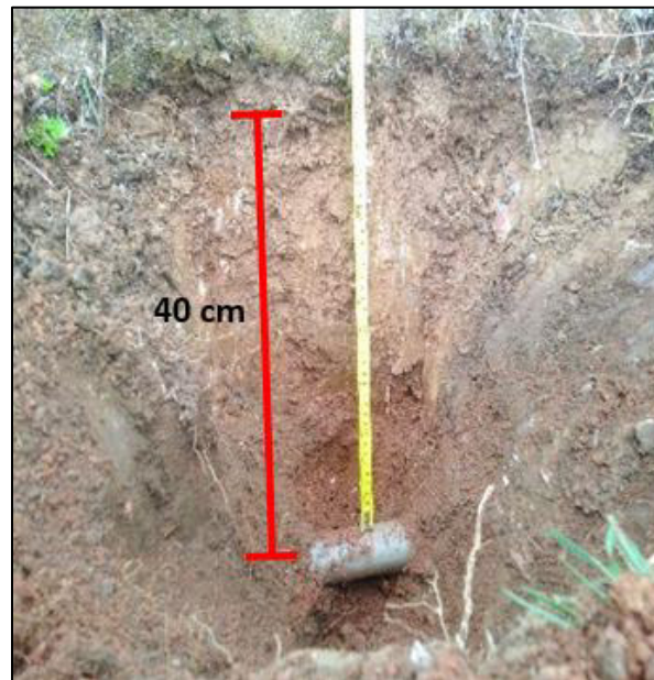
Figura 11. Línea de aducción a una profundidad de 40cm. Fuente: El Consultor
