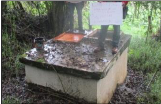
Figura 20. Captación existente tipo ladera la ruda. Fuente elaboración propia
