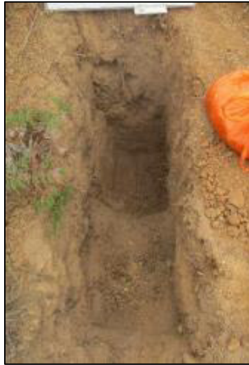
Figura 12. Calicata realizada en la Línea de conducción a una profundidad de 1.00m. Fuente: El Consultor
