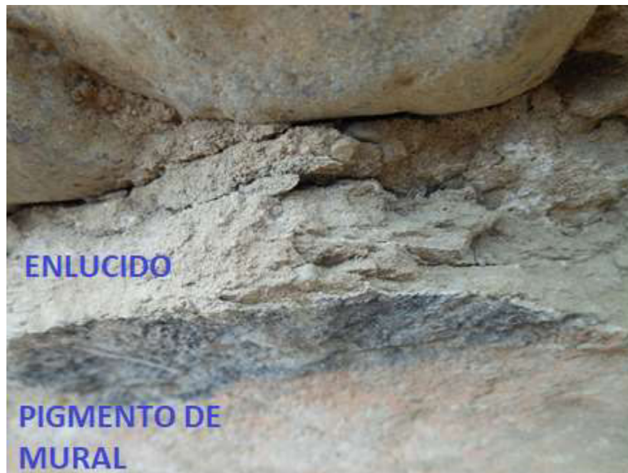
Figura 5. Vista transversal parcial del Mural 1, donde se puede distinguir el enlucido y el pigmento del mural. (© Programa Arqueológico Huanchaco)
