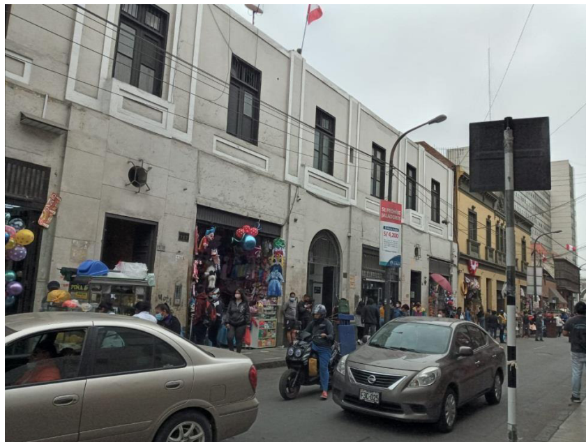
Uso de inmuebles patrimoniales para fines comerciales – Jr. Huallaga Cdra. 7
