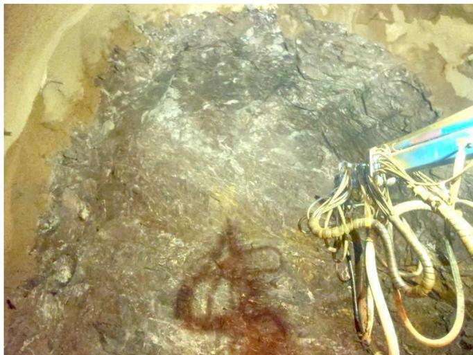
*Figura 5.23.* Progresiva 2+189.60. Roca tipo III, avance en este tramo de 3 metros, la roca presenta alto a moderada resistencia a la compresión simple.
