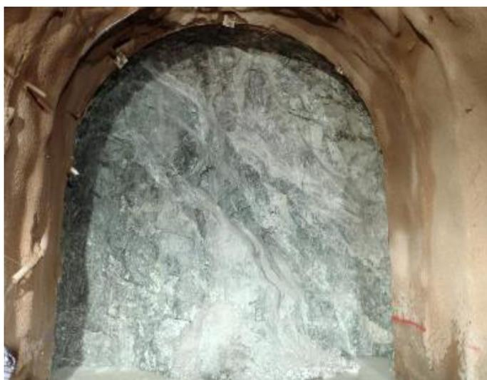
*Figura 5.8.* Grupo Casma, Miembro inferior (Kicas/v). Andesita, con fallas geológicas rellenas de clorita, arcilla expansiva., progresiva 1+659.50.
