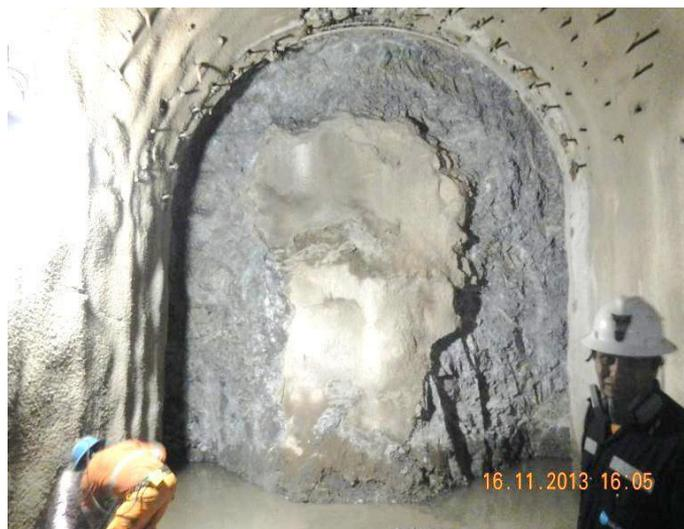
*Figura 5.20.* Progresiva 2+166.60. Roca tipo IV, la excavación se sigue en la falla geológica compuesta de arcilla y material deleznable, los avances por excavación es menor a 1.2 metros.
