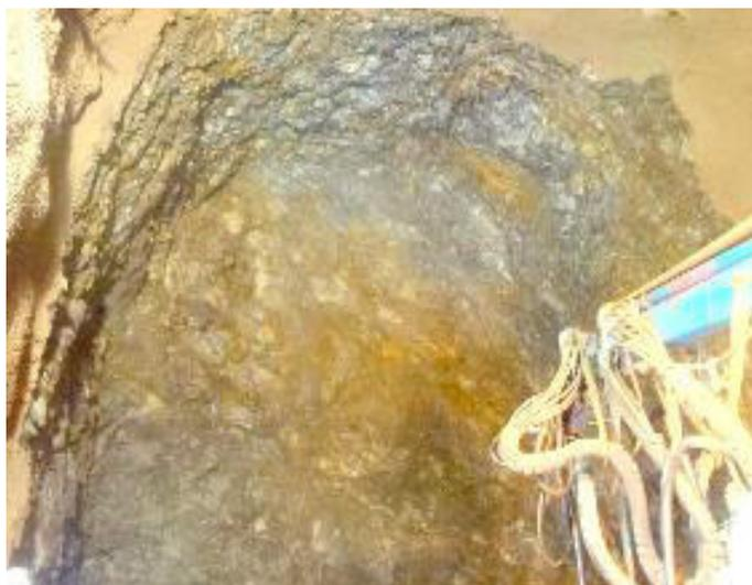
*Figura 5.18. Progresiva 2+148.70. Roca tipo III, presencia de óxidos en bóveda y en la parte superior del frente de avance.*
