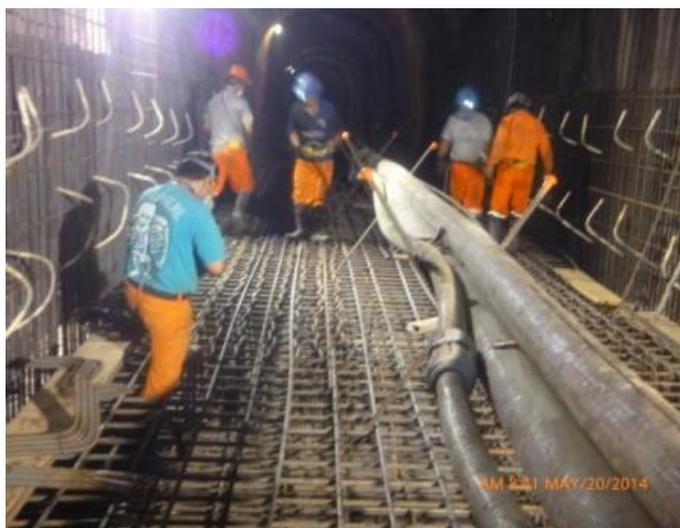
*Figura 5.30.* Tramo 1+020 – 1+025. Ejecución del invert o concreto armado en el piso como
