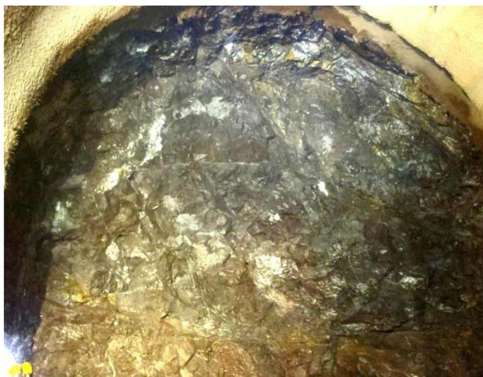
*Figura 5.22.* Progresiva 2+182.90. Roca tipo III, la roca andesita presenta bajo grado de meteorización, se evidencia presencia de cuarzo relleno las fracturas.
