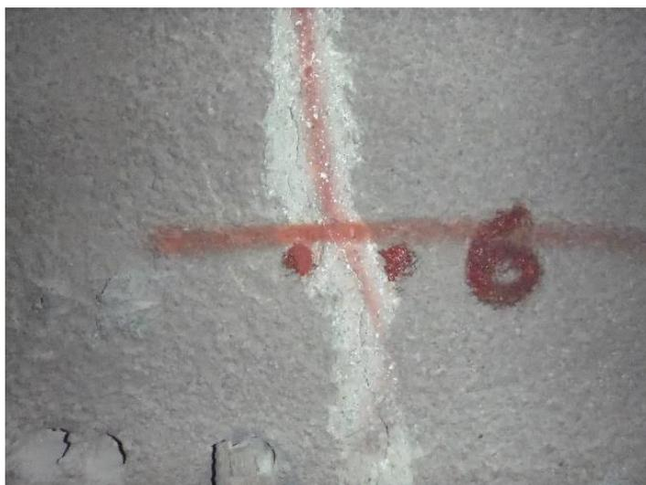
*Figura 5.25.* Progresiva 1+037. Se evidencia fisura vertical en el concreto lanzado.
