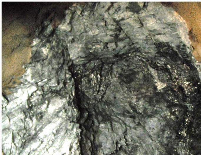
*Figura 5.12.* Progresiva 1+006.80. La clasificación geomecánica evidencia roca tipo IV, presencia de carbón, las fracturas en la roca se encuentran rellenas de arcilla, producto de la descomposición del carbón.
