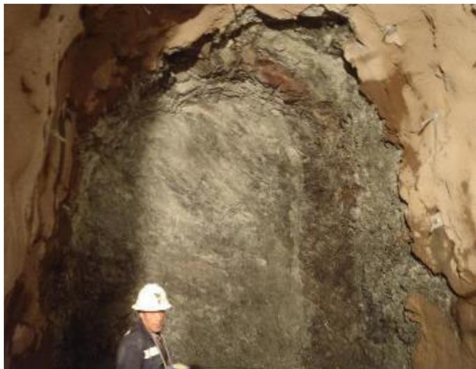
*Figura 5.7.* Grupo Casma, Miembro inferior (Kicas/v). Andesita con presencia de humedad y zonas de óxidos, progresiva 1+558.50.
