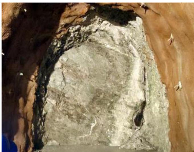
*Figura 5.6.* Grupo Casma, Miembro inferior (Kicas/v). Zona de falla geológica, toba verdosa, capas con dirección de buzamiento 05°-10° y buzamiento 68°; progresiva 1+549.70.
