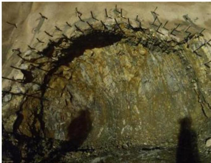
*Figura 5.2.* Formación Chimú, arenisca cuarzosa meteorizada intercalada con capas de limoarcillitas.
