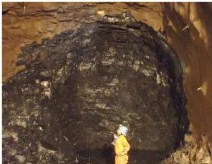
*Figura 5.16.* Progresiva 1+170.20. Roca tipo III, presencia de carbón, la roca presenta leve meteorización.
