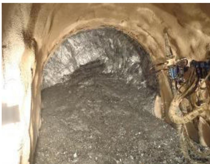
*Figura 5.14.* Progresiva 1+067.50. Tramo de roca tipo IV, presencia de carbón, avances menores a 1 metro.
