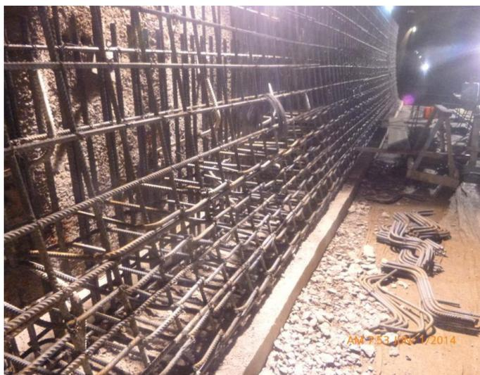
Figura 5.35. Tramo 2+145 – 2+165. Ejecución del sostenimiento final denominado concrete lining.
