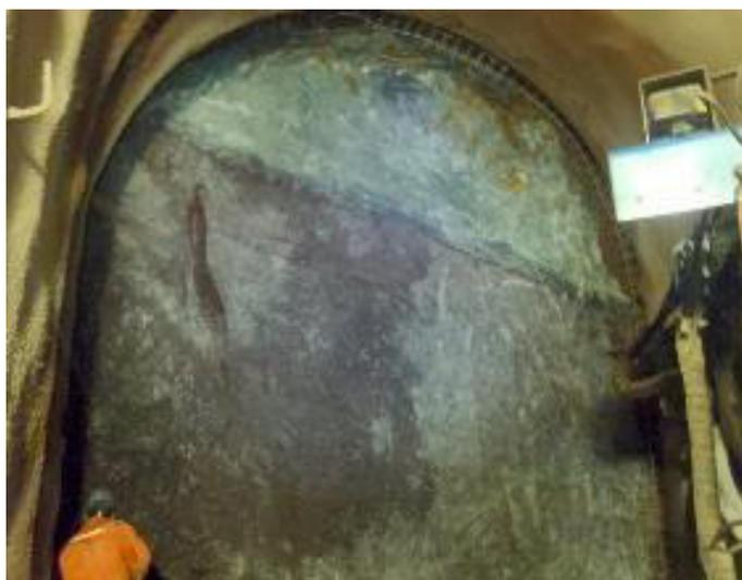
*Figura 5.19.* Progresiva 2+159.50. Roca tipo IV, se evidencia presencia de falla sub horizontal, con dirección de buzamiento de  $10^\circ$  y buzamiento de  $25^\circ$ .
