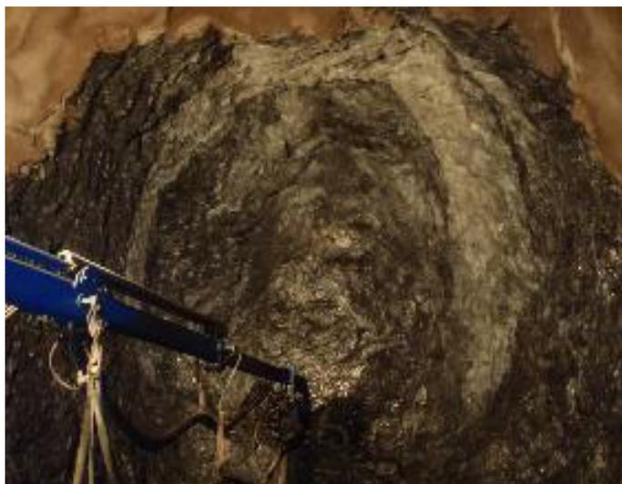
*Figura 5.17.* Progresiva 1+316.00. Roca tipo III, se evidencia presencia de falla sub vertical, rellena de arcilla, producto de la descomposición de la roca ígnea.
