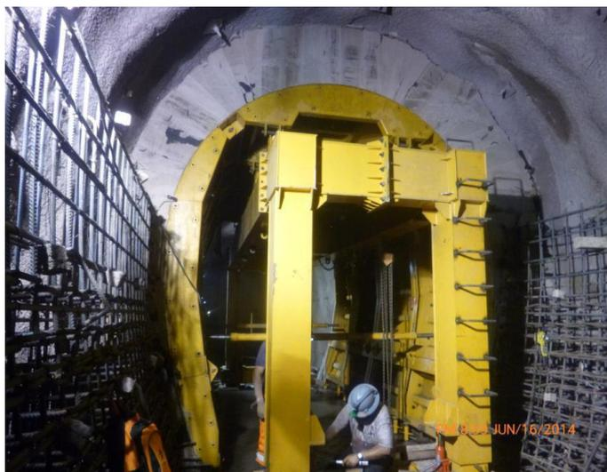
*Figura 5.37.* Tramo 2+145 – 2+165. Ejecución del sostenimiento final denominado concrete lining.
