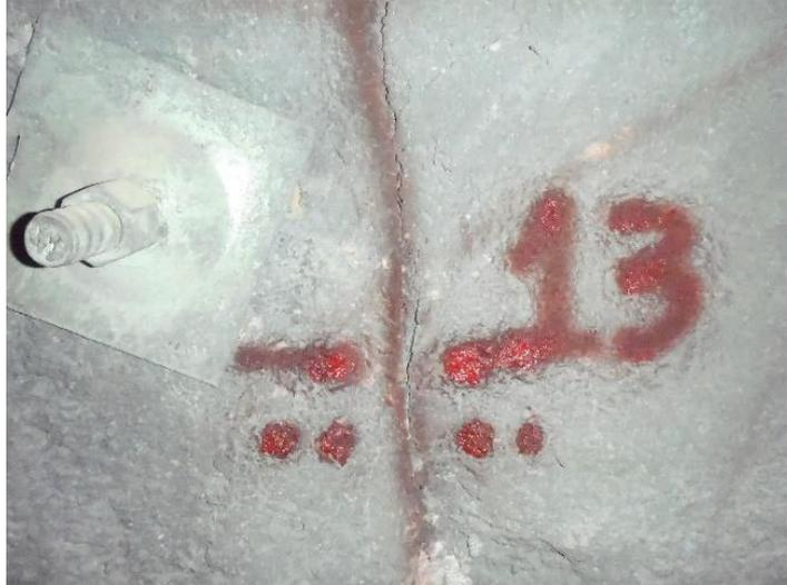
*Figura 5.26.* Progresiva 1+107. Se evidencia fisura vertical en el concreto lanzado.
