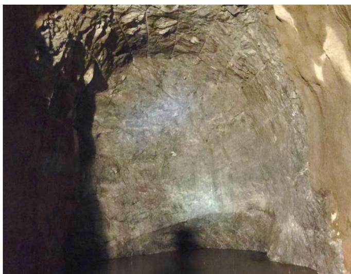
*Figura 5.10.* Progresiva 0+951.20. Roca tipo II, avance del frente de 3.1 metros, buen autosostenimiento y alta resistencia a la compresión uniaxial como propiedades de la roca.
