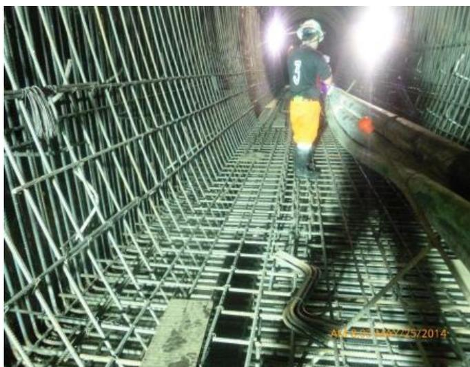
*Figura 5.32.* Tramo 1+190 – 1+200. Ejecución del invert o concreto armado en el piso como parte del sostenimiento final denominado concrete lining.
