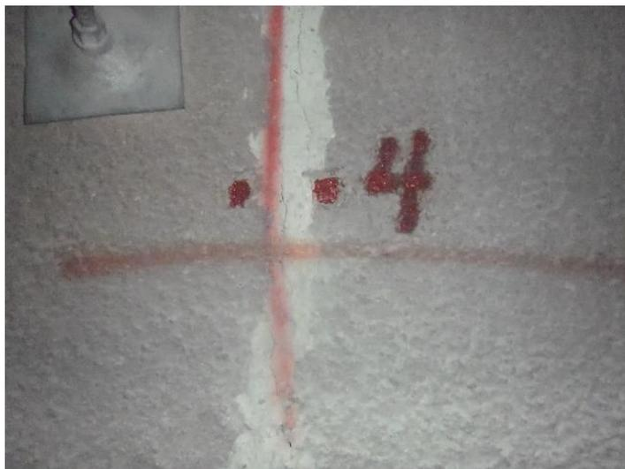
*Figura 5.24.* Progresiva 1+031.5. Se evidencia fisura vertical en el concreto lanzado.
