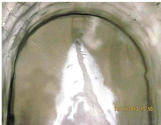
*Figura 5.21.* Progresiva 2+168.20. Roca tipo IV, se evidencia presencia de agua en la parte superior de la cara del frente de avance.
