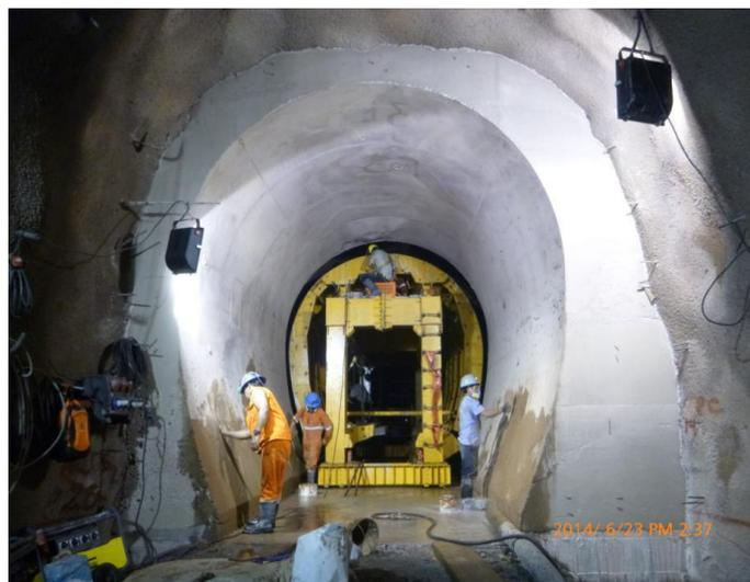
*Figura 5.34.* Tramo 1+150 – 1+160. Ejecución del sostenimiento final denominado concrete lining.
