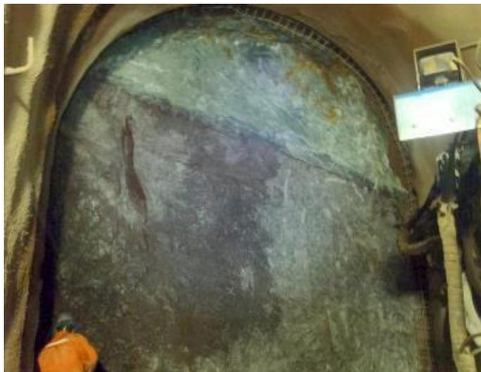
*Figura 5.9.* Grupo Casma, Miembro inferior (Kicas/v). Andesita, con presencia de falla geológica rellena de mineral expansivo con dirección de buzamiento  $10^{\circ}$ - $15^{\circ}$  y buzamiento  $20^{\circ}$ - $30^{\circ}$ , progresiva 2+159.50.
