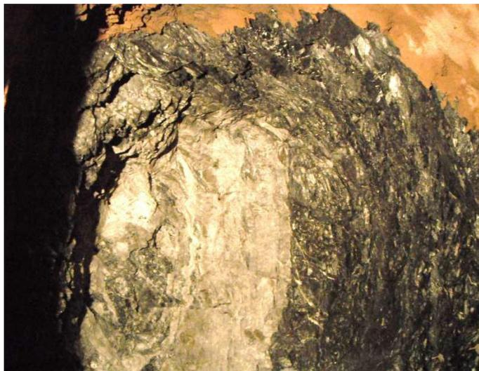
*Figura 5.13.* Progresiva 1+013.50. Tramo de roca tipo III, según evaluación geomecánica, la sección luego de la excavación es irregular, aun se notan presencia de fallas rellenas de arcilla, planos de discontinuidades sub verticales cortando perpendicularmente al eje del túnel.
