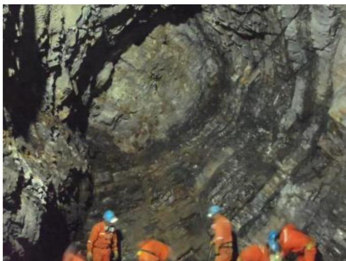
*Figura 5.3.* Formación Chimú, areniscas cuarzosas intercaladas con estratos delgados de carbón, capas con dirección de buzamiento  $15^{\circ}$ - $20^{\circ}$  y buzamiento  $45^{\circ}$ - $50^{\circ}$ ; progresiva 0+144.90.
