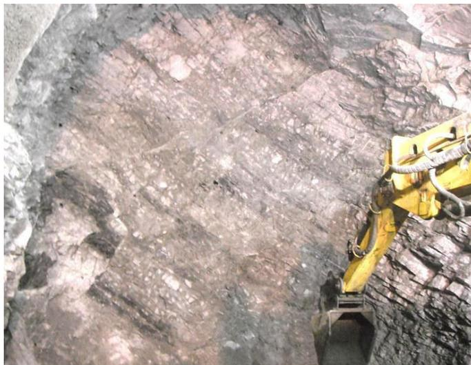
*Figura 5.4.* Formación Chimú, areniscas cuarzosas intercaladas con estratos delgados de carbón, capas con dirección de buzamiento  $200^{\circ}$ - $210^{\circ}$  y buzamiento  $50^{\circ}$ - $65^{\circ}$ ; progresiva 0+347.10.
