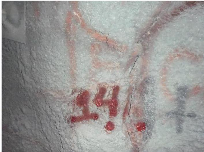
*Figura 5.27.* Progresiva 1+105. Se evidencia fisura vertical en el concreto lanzado.
