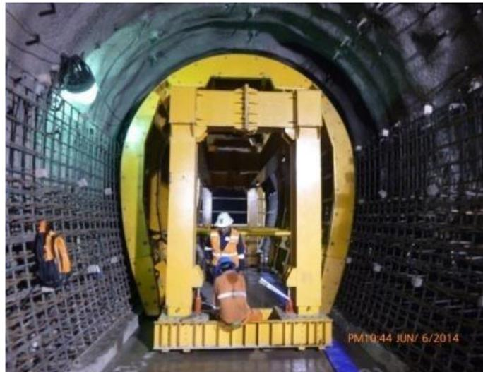
*Figura 5.33.* Tramo 1+150 – 1+160. Ejecución del sostenimiento final denominado concrete lining.
