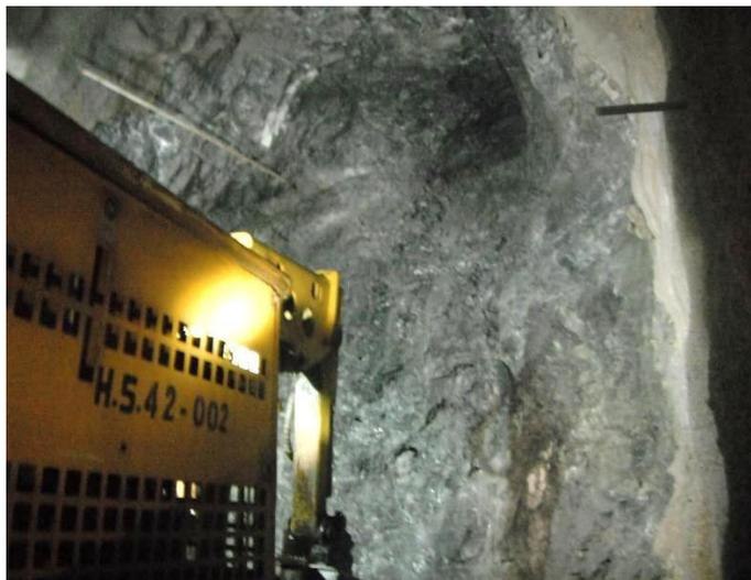
*Figura 5.11.* Progresiva 0+975.00. Clasificada como roca tipo III, moderado a buen autosostenimiento, se evidencia presencia de carbón en la parte superior de la cara del frente.
