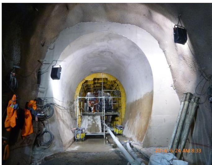
*Figura 5.38.* Tramo 2+145 – 2+165. Ejecución del sostenimiento final denominado concrete lining.
