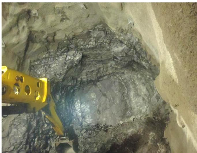
*Figura 5.5.* Formación Chimú, areniscas cuarzosas intercaladas con estratos delgados de carbón, fracturas rellenas de calcitas, capas con dirección de buzamiento  $10^{\circ}$ - $15^{\circ}$  y buzamiento  $70^{\circ}$ - $75^{\circ}$ ; progresiva 0+742.70.
