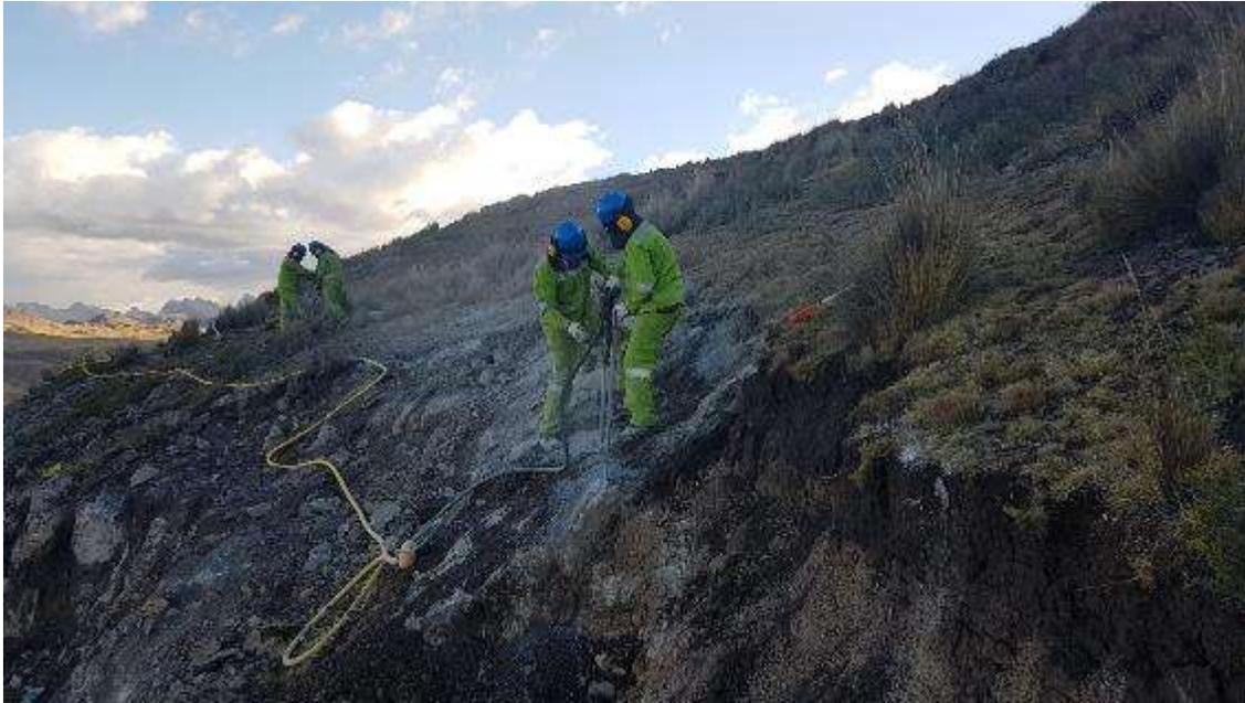
Taladros perforados con equipo mecanizado hidraulico en plataforma
