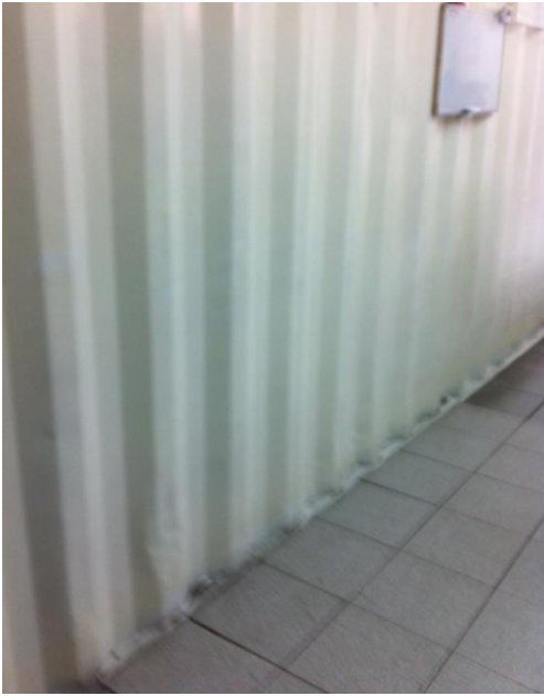
Figura14. Pasadizo principal. Fuente: Registro fotográfico.
