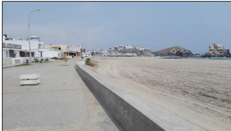
Fotografía 6.4 Reforzamiento y mantenimiento de las viviendas frente al malecón norte que se encuentran expuestos además del sismo al consecuente tsunami, Cercado de Punta Negra Zona Central (registro propio de setiembre, 2017).
