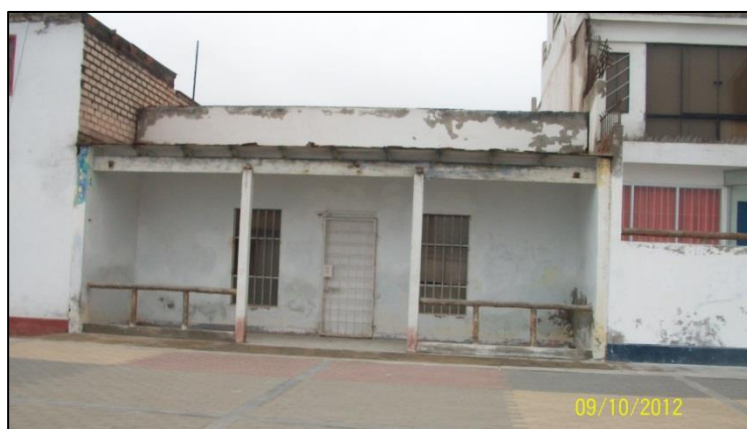
Fotografía 4.6 Vivienda de mampostería (material de construcción medianamente resistente), Cercado de Punta Negra Zona Central (registro propio de octubre, 2012).
