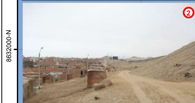
2 Viviendas del sector Costa Azul zona A le corresponde isoperiodos 0.3-0.4s, cuya amplitud sísmica puede ser de mediana intensidad. Registro fotográfico (16 de noviembre del 2012, distrito de Punta Negra).
