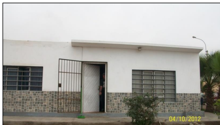
Fotografía 4.1 Viviendas en buen estado de conservación (indica menor grado de vulnerabilidad por fragilidad), Cercado de Punta Negra Zona Central (registro propio de octubre, 2012).
