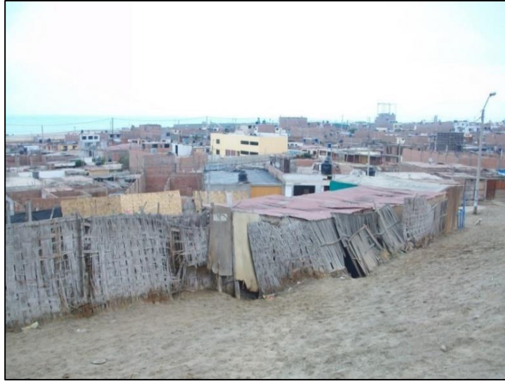
Fotografía 3.5 Viviendas de estera ubicada en la Asoc. de Viv. Costa Azul Zona A. (registro propio de octubre, 2012).
