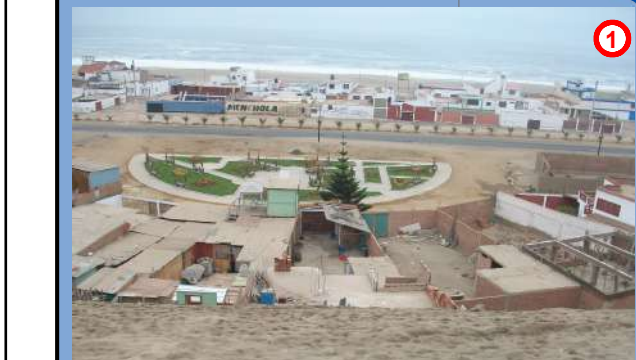
1 Urbanización La Merced con periodo dominante 0.2s, le corresponde suelos estables; sin embargo las laderas pueden ser un factor de inestabilidad para las viviendas asentadas. Registro fotográfico (22 de noviembre del 2012, distrito de Punta Negra).
