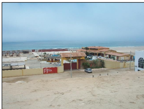
Fotografía 6.7 Inspección y reforzamiento del Centro Recreacional CAFAE-MININTER, Cercado de Punta Negra Zona Sur (registro propio de diciembre, 2012).
