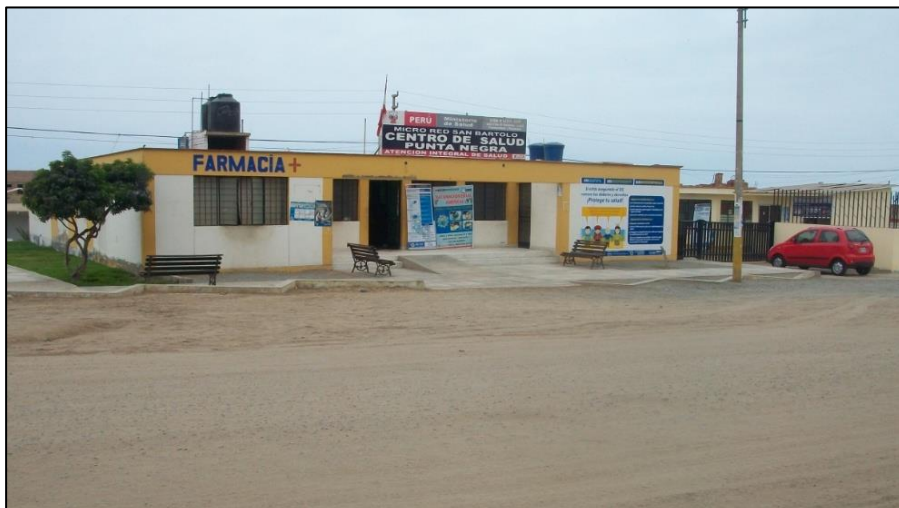
Fotografía 3.6 Centro de Salud ubicada en Punta Negra Zona Centro (registro propio de octubre, 2012).
