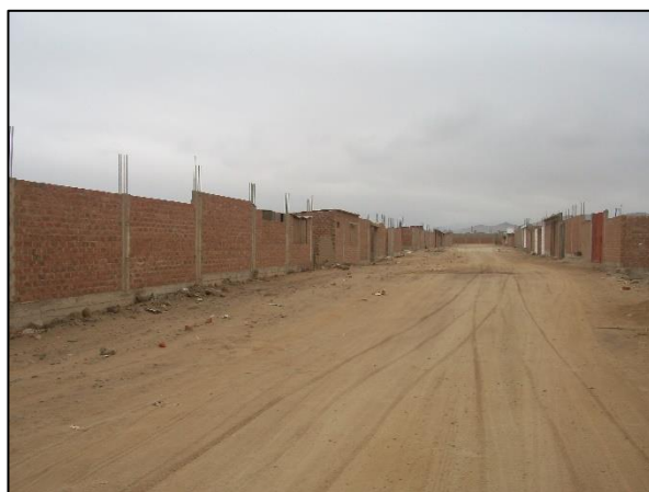
Fotografía 6.8 Viviendas de la Asoc. de Viv. Juventud El Bosque en proceso de consolidación requieren la inspección y evaluación de las construcciones según las normas sismorresistentes (registro propio de noviembre, 2012).
