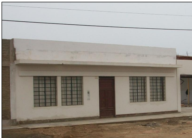
Fotografía 4.2 Viviendas en regular estado de conservación (indica que el grado de vulnerabilidad por fragilidad puede ser regular), Cercado de Punta Negra Zona Sur (registro propio de octubre, 2012).
