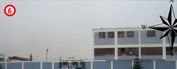
Centro Educativo Nacional Primario Ruddy Echegaray se encuentra en la Mz. A1 lote 94 del Cercado de Punta Negra Zona Sur. Por sus condiciones físicas estructurales presentaría riesgo bajo ante un evento sísmico; debido a los suelos intermedios, además no se vería afectado por el tsunami. Registro fotográfico (08 de diciembre del 2012, distrito de Punta Negra).
