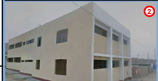
Centro Educativo Particular ubicado en la Mz. G1 lote 2 de la Asoc. de Viv. Costa Azul Zona B. El nivel de peligro bajo se debe a las condiciones del suelo de tipo intermedio y por encontrarse fuera del alcance de inundación por tsunami; sin embargo la vulnerabilidad aumenta debido a la resiliencia de la población. Tomada de Google Earth, 2019 (Fecha de imagen febrero, 2013).
