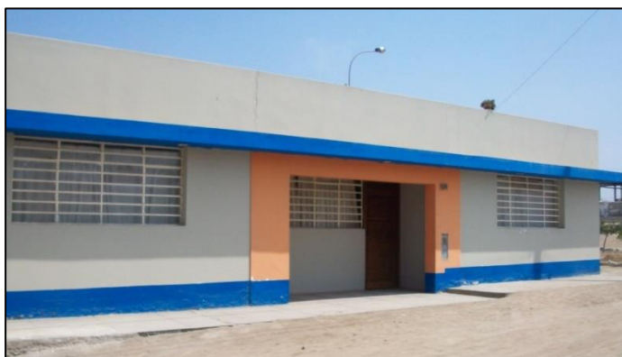
Fotografía 4.8 Vivienda con alero (poca probabilidad de vulnerabilidad), Cercado de Punta Negra Zona Central (registro propio de octubre, 2012).
