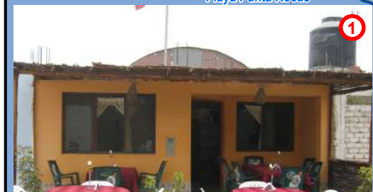
Restaurante ubicado en la Mz. S1 lote 4B en la Asoc. de Viv. Costa Azul Zona C. Las condiciones físicas estructurales la definen en riesgo medio; por otro lado el nivel de peligro bajo se debe a las buenas condiciones del suelo ante la acción de un sismo; además se encontraría fuera del área de inundación por tsunami. Registro fotográfico (16 de noviembre del 2012, distrito de Punta Negra).
