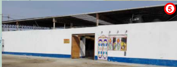
Mercado de abastos localizado en la Mz. A', lote 183 en el Cercado de Punta Negra Zona Sur. Estructuralmente tiene vulnerabilidad media, principalmente por la concurrencia de la población, pero el nivel de peligro es bajo porque se encuentra sobre suelos intermedios y no se vería afectado por el tsunami. Registro fotográfico (23 de setiembre del 2017, distrito de Punta Negra).
