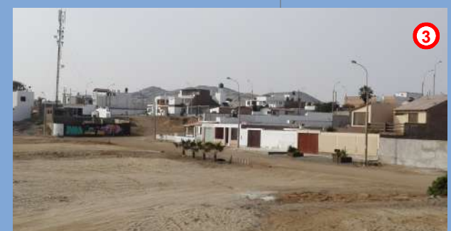
3. Antena de aproximadamente 30m de altura ubicado sobre el techo de una vivienda (sin seguridad) en el Cercado de Punta Negra Zona Central ante la caída puede afectar a 5 viviendas aledañas. Registro fotográfico (23 de setiembre del 2017, distrito de Punta Negra).
