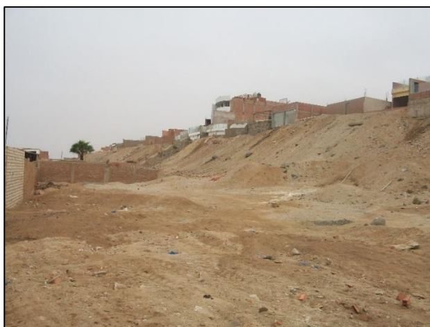
Fotografía 6.6 Viviendas ubicadas sobre laderas de suelos inestables (Asoc. de Viv. Santa Rosa Alta), requieren cercos o muros de contención que evite el deslizamiento o caída de rocas sobre las viviendas de la Asoc. de Viv. Santa Rosa Baja (registro propio de noviembre, 2012).
