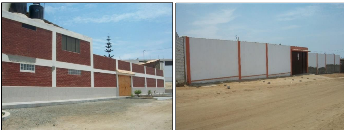
Fotografías 4.15 Centro de Rehabilitación (zona peligrosa para la seguridad de los pobladores, debido a la ausencia de las autoridades), Asoc. de Viv. Santa Rosa Alta frente a la Calle Cazón (registro propio de setiembre, 2017).
