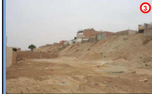
3 En la parte alta se localizan las viviendas en la asociación Santa Rosa Alta, sobre depósito marino-aluvial T2. La zona se encuentra con viviendas en proceso de construcción y falta de muros de contención. Registro fotográfico (13 de noviembre del 2012, distrito de Punta Negra).
