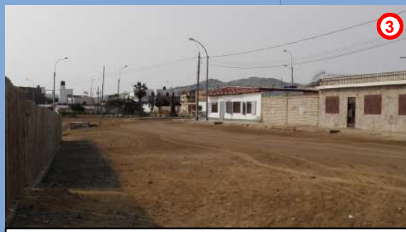
3 Comportamiento sísmico-geotécnico que corresponde a la Zona II. Concentra el 70% del área urbana del distrito. Registro fotográfico (23 de setiembre del 2017, distrito de Punta Negra).
