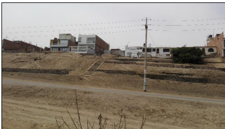
Fotografía 6.1 Evaluación y reforzamiento de los muros de contención en talud, AA. HH. Villa Mercedes (registro propio de setiembre, 2017).
