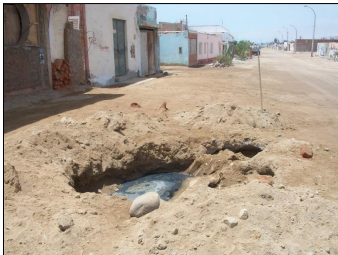
Fotografía 3.12 Exposición de aguas servidas, ubicada en Punta Negra Zona Sur (registro propio de octubre, 2012).
