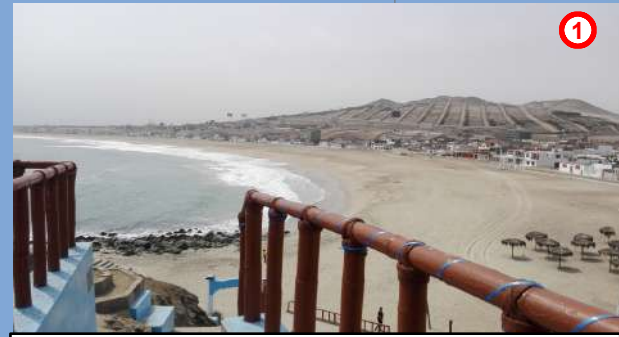
1 La acción del tsunami de magnitud 8.5 Mw. afectaría todas las viviendas del Cercado de Punta Negra Zona Norte y Urb Punta Rocas. Registro fotográfico (23 de setiembre del 2017, distrito de Punta Negra).
