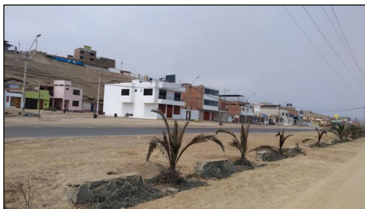
Fotografía 4.12 La acción del tsunami cruzaría la antigua autopista Panamericana Sur afectando a las viviendas cercanas a la carretera (se encuentra a 10 m.s.n.m.), Asoc. de Viv. La Merced (registro propio de setiembre, 2017).
