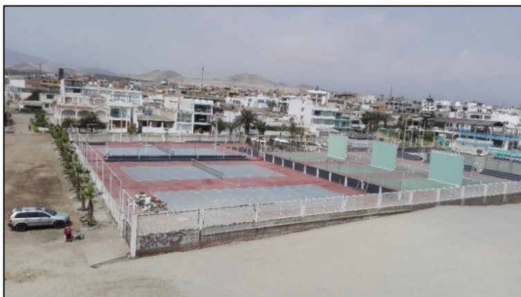
Fotografía 4.11 El área de inundación afectaría el centro recreacional (se encuentra a 5 m.s.n.m.), Cercado de Punta Negra Zona Central (registro propio de setiembre, 2017).
