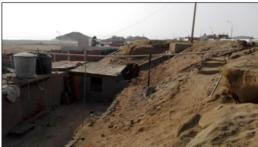
Fotografía 3.8 Malas prácticas de conexiones de agua, ubicada en Punta Negra Zona Sur (registro propio de setiembre, 2017).
