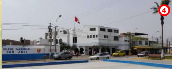
La Municipalidad distrital se encuentra en la Mz. F1, lote 9 del Cercado de Punta Negra Zona Centro. La Institución administrativa principal se encontraría en riesgo bajo debido a su localización sobre suelos rígidos y a la infraestructura que presentaría baja vulnerabilidad física. Registro fotográfico (23 de setiembre del 2017, distrito de Punta Negra).
