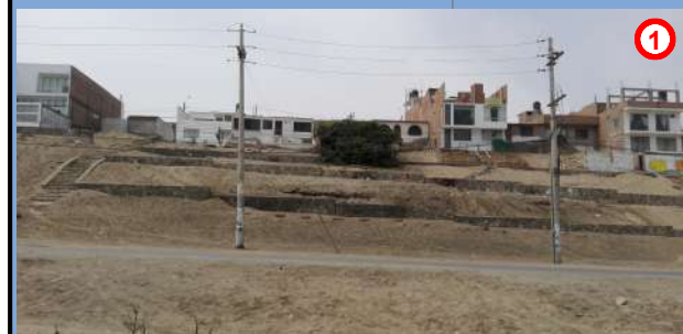
1 Viviendas asentadas sobre depósito marino-aluvial T2 (7 metros de altura con respecto al nivel del mar), ubicado en el AA.HH. Villa Mercedes. El talud presenta muros de contención para darle mayor estabilidad al terreno. Registro fotográfico (23 de setiembre del 2017, distrito de Punta Negra).
