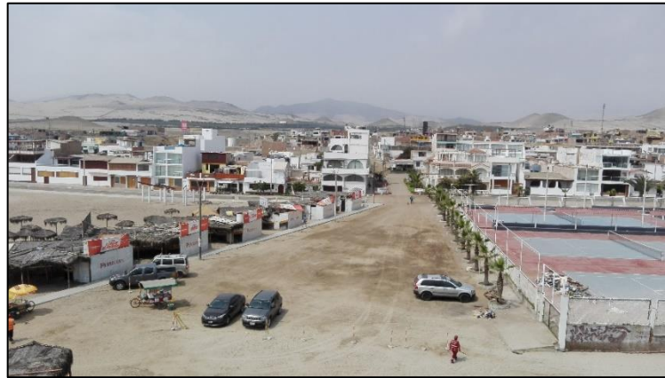
Fotografía 6.10 Ruta de evacuación del Centro de Recreación Central, Cercado de Punta Negra Zona Norte (registro propio de setiembre, 2017).
