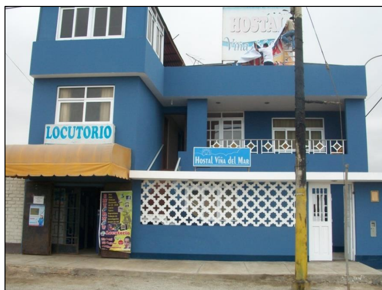
Fotografía 4.10 Hospedaje con alero (diseño de la vivienda que sobrecarga los niveles inferiores generando fragilidad física), Asoc. de Viv. La Merced (registro propio de octubre, 2012).
