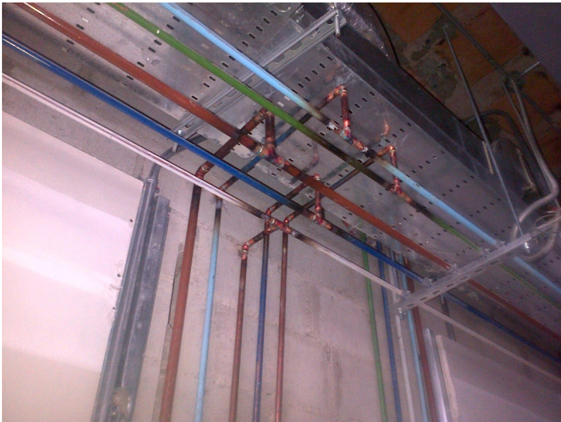
Fig. 11 Instalación de Tuberías de Cobre Bajo la NFPA 99
