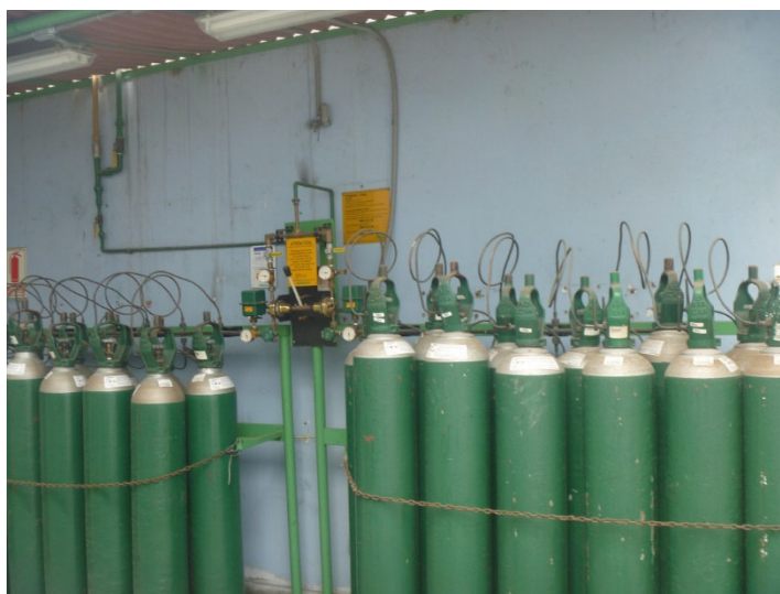
Fig. 1 Manifold de Oxígeno Medicinal
