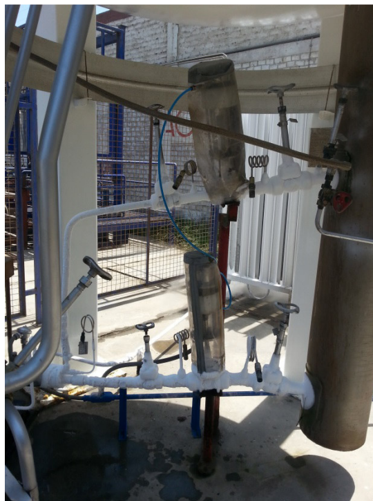
Fig. 24 Tubería de Acero Inoxidable en Tramo de Oxígeno Líquido a la Succión y Retorno de Bomba Criogénica
