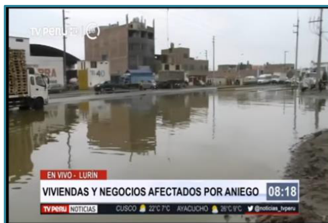
Figura 10. Aniego en zona A Lurín por desborde de laguna de oxidación proyecto Mesías
