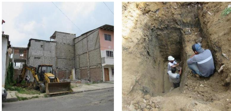
**Figura: 20** Excavación de calicatas C04 en el sector urbano de la ciudad de Esmeraldas, donde se identificaron dos niveles sedimentarios de depósitos de tsunamis
