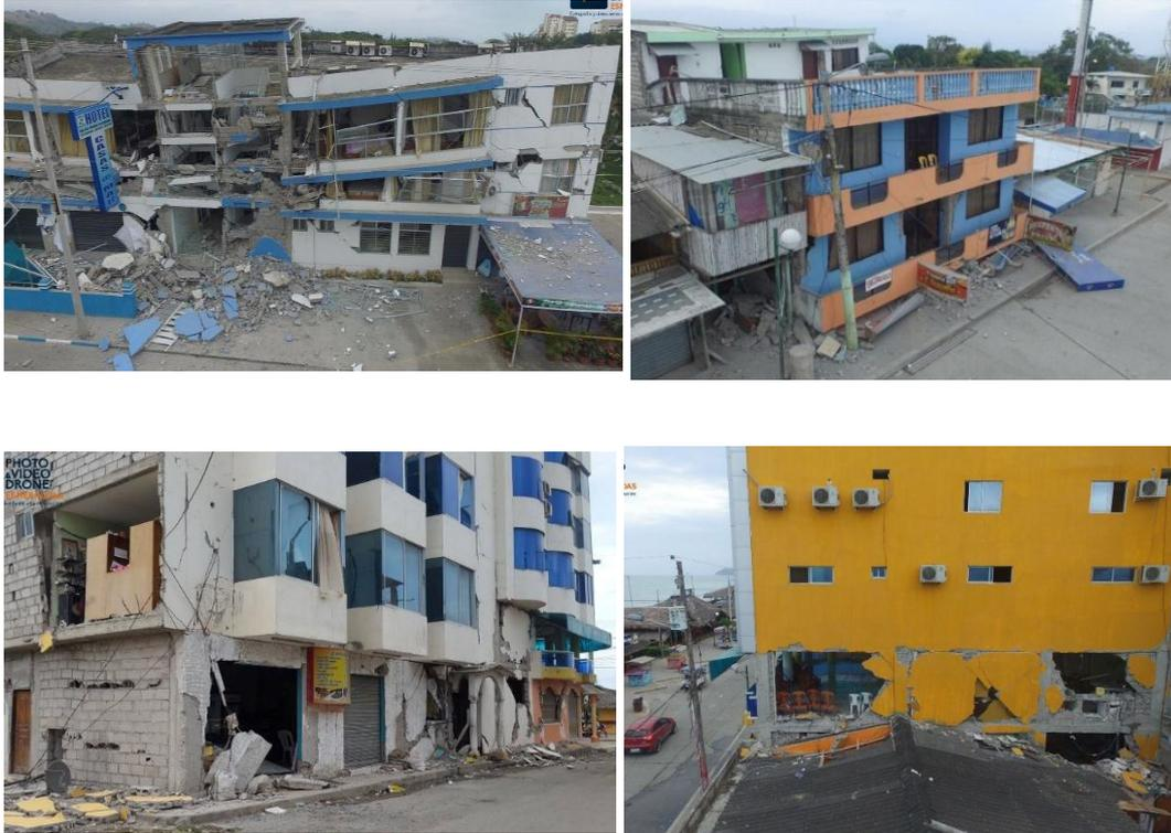
**Figura: 7** Daños estructurales causados por el sismo del 19 de diciembre de 2016 ( $M_w$  5.4, hipocentro 4 km). Imágenes superiores de izquierda a derecha referidas al colapso de cimentaciones en el sitio Atacames. Imágenes inferiores de izquierda a derecha, referidas al sitio Tonsupa, provincia de Esmeraldas. Cortesía de fotos: "photo & video drone Esmeraldas".
