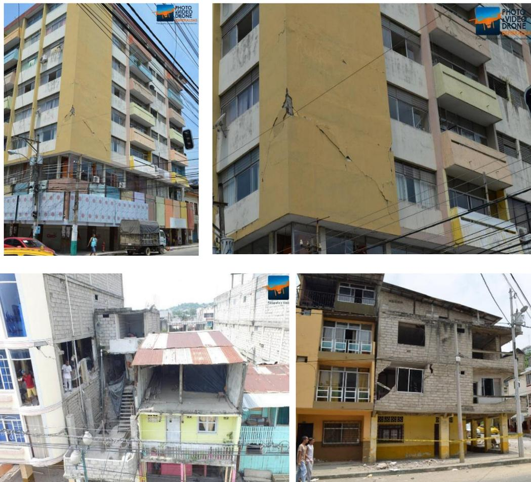
**Figura: 5** Daños menores en el centro de la ciudad de Esmeraldas por el sismo de Pedernales del 16 de abril 2016 (Mw 7.8). Imágenes superiores de izquierda a derecha referidas a la dirección Bolívar y Manuela Cañizares (650059.5E-106660.6N). Imágenes inferiores de izquierda a derecha, referidas a las direcciones 6 de Diciembre y Piedrahita (649688.7E-106169.1N), y Ricaurte entre Colon y Eloy Alfaro (64984.2E-106322.7N). Cortesía de fotos: “photo & video drone Esmeraldas”.
