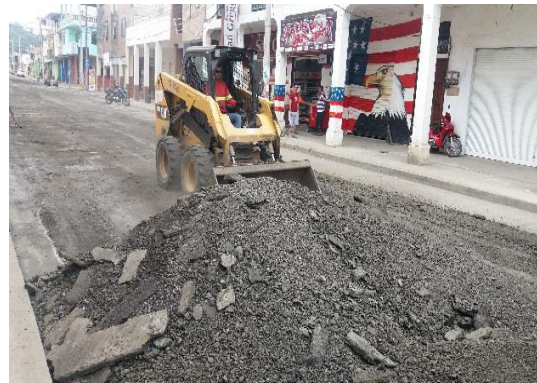
Acopio de pavimento asfáltico envejecido para posterior desalojo
