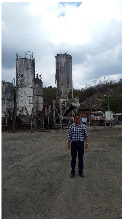
Planta de asfalto y hormigones Caja Fuego
