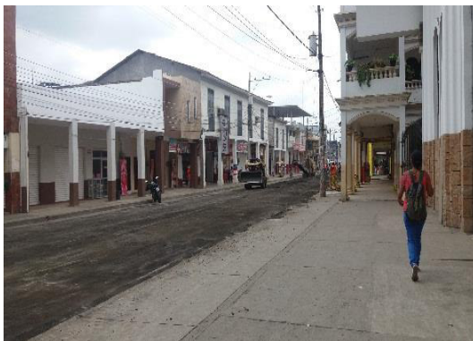
Reciclado del pavimento asfáltico envejecido, calle 10 de Agosto ciudad de Calceta
