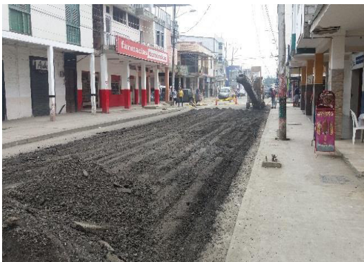
Remoción de reciclados de pavimento asfáltico envejecido
