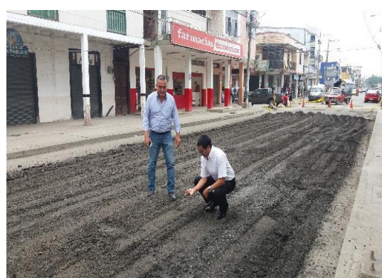
Inspección de los reciclados de pavimento asfáltico envejecido
