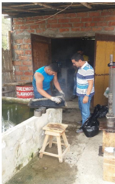
Mezcla de materiales con asfalto
