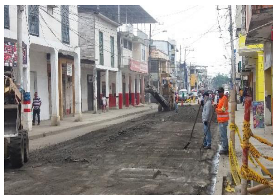
Reciclado del pavimento asfáltico envejecido, calle 10 de Agosto ciudad de Calceta
