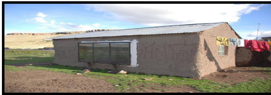
Figura N°21. Casa de adobe aplicando el Muro Trombe
