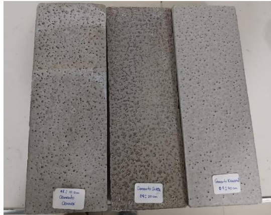
Figura 3: Bloques de grout 100 con problemas de exudación
