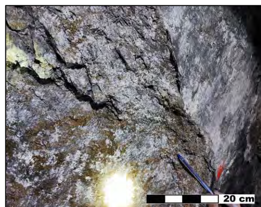
Figura 47. Alteración en el contacto entre la veta y la roca caja constituida por arcillas y diseminaciones de pirita y algunos óxidos producidos por el contacto con el agua.
