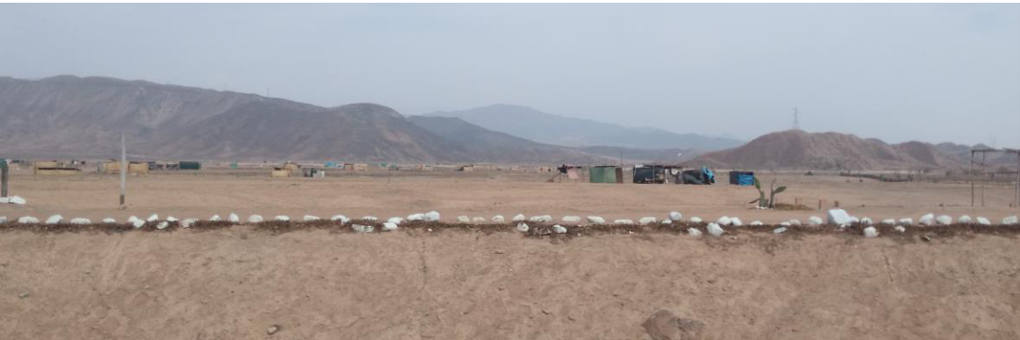
Figura 13. Fotografías realizadas a las construcciones precarias del Sector 1
