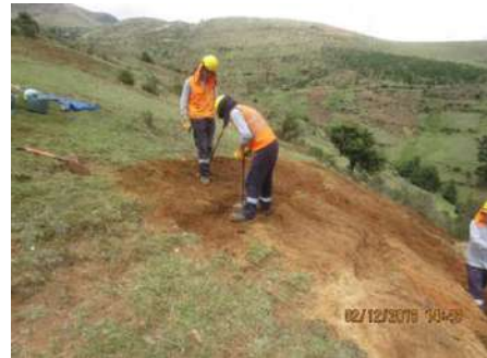
Instalación de contrapeso
