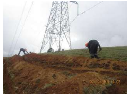
Instalación de contrapeso
