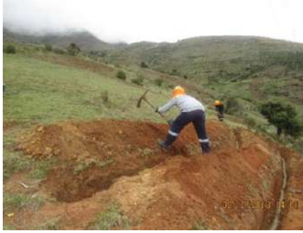
Instalación de contrapeso
