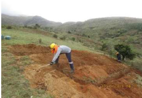
Instalación de contrapeso
