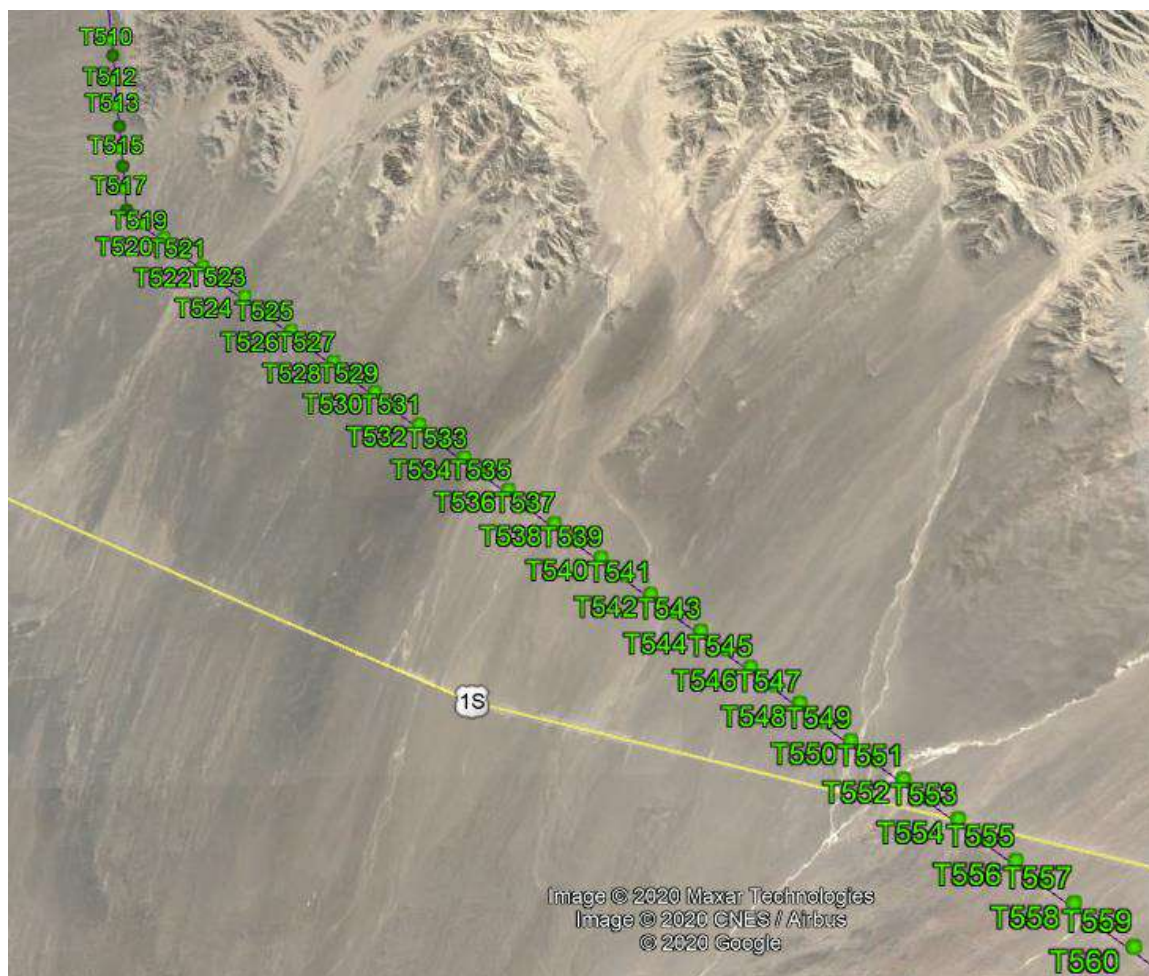
Figura 3. Ubicación vía Google Earth de estructuras a evaluar de línea L-5032.
