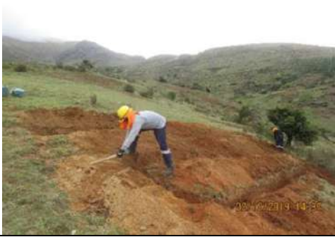
Instalación de contrapeso
