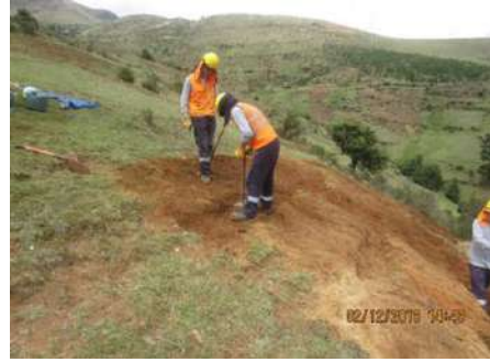
Instalación de contrapeso
