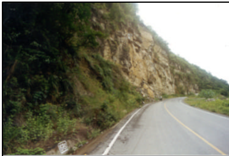
Foto 19.- Mirando al Oeste desde la progresiva 271+340, al fondo afloramiento de calizas en capas medianas a gruesas. Nótese desprendimientos de bloques y bloques caídos
