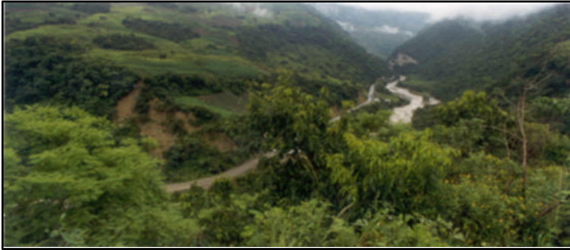
Foto 22.- Deslizamiento activo escalonado en las lutitas de la Fm. Quilquiñan, próximo al poblado Pueblo Nuevo entre los Km..275+000 a 276+000
