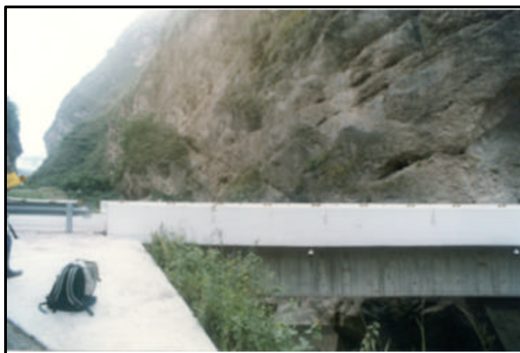
Foto 7.- Foto tomada desde el Puente Corontacacha hacia el SE, nótese estratificación de N-50°-O e inclinación de 30° SO, capas de calizas brechosas, masivas y compactas de la Fm. Corontachaca
