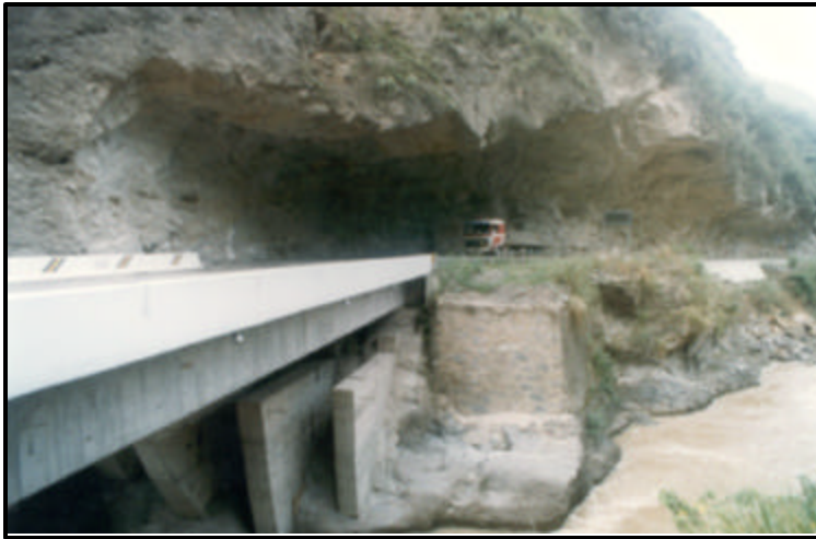
Foto 9.- Puente Corontachaca, nótese talud artificial en calizas brechosas de la Fm. Corontachaca, cuyo macizo reúne buenas características en el Km. 299+000
