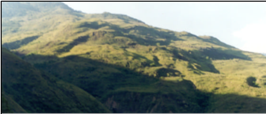
Foto 23.- Deslizamiento antiguo escalonado y estabilizado entre las progresivas 290+000 a 291+000
