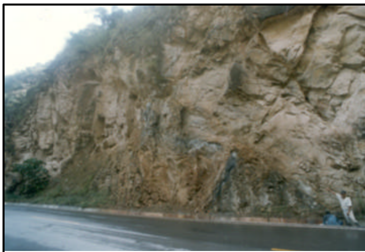
Foto 18.- Sobreescurrecimiento de areniscas rojas del Grupo Mitu sobre la caliza de la Fm. Chambará en la progresiva 269+890 (G-11)
