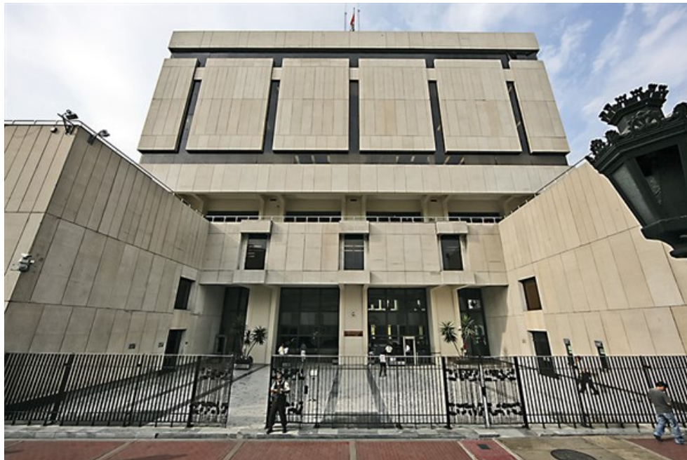
Figura 2: Sede Central del BCRP
