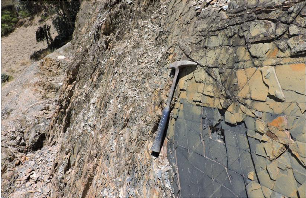
Figura 4.7: Detalle de las lutitas con laminación paralela de la Formación Tinajones, en el Cerro Incatanan, en el corte de carretera que va del distrito de La Merced a la Mina Huinac.
