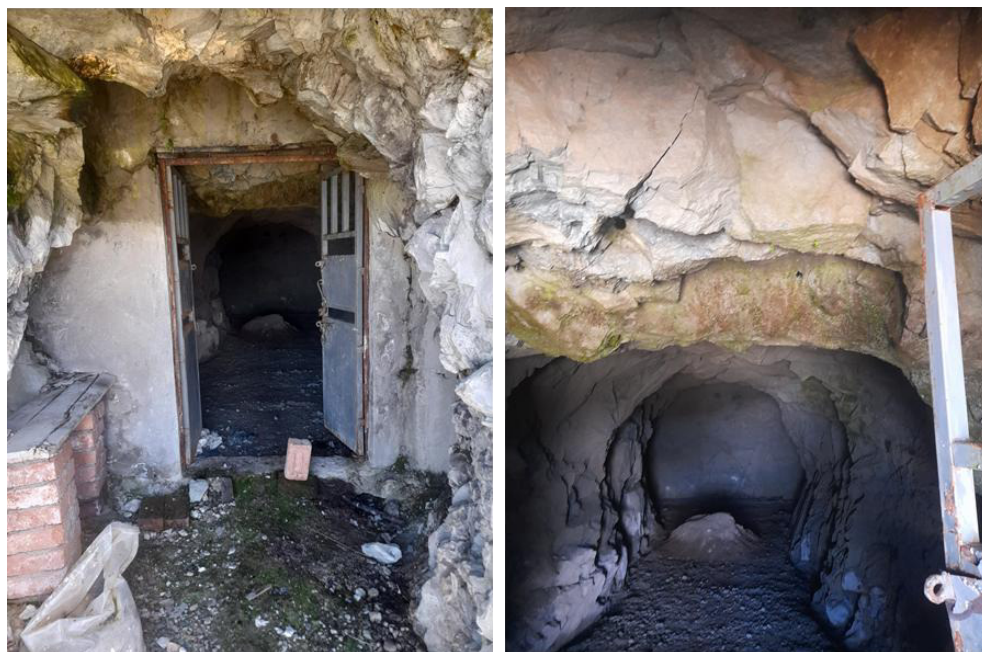
Figura 8: Fotografías del ingreso al antiguo polvorín subterráneo
