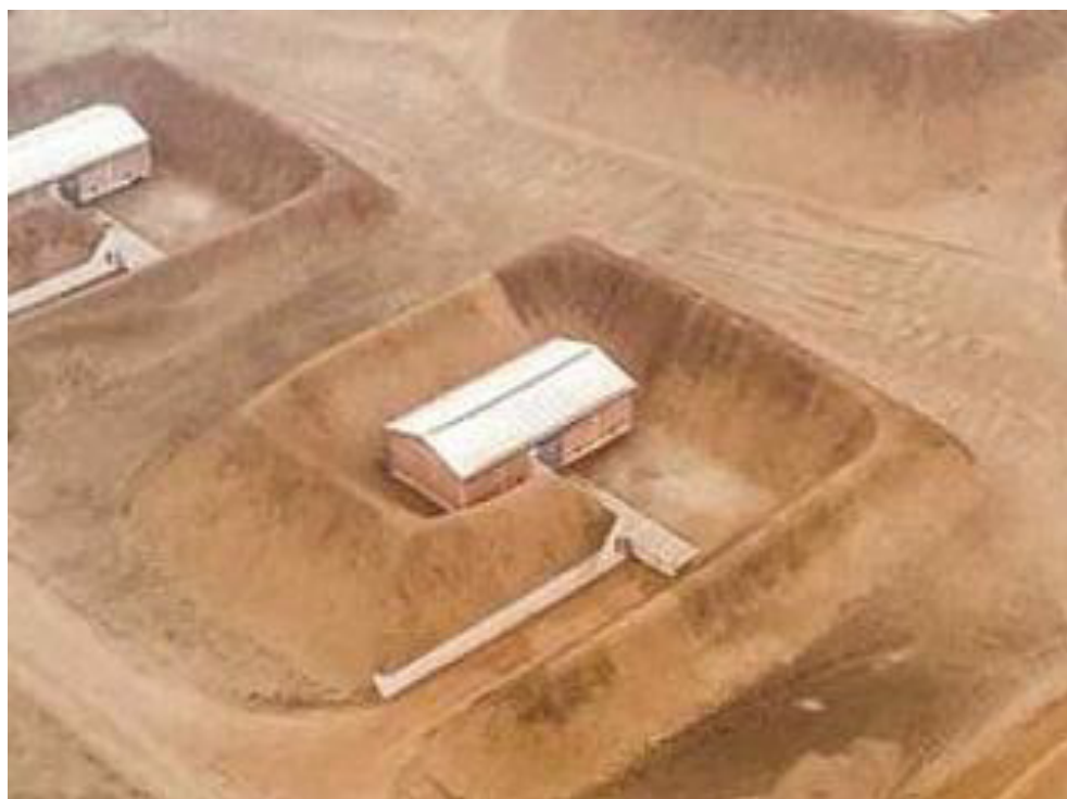
Figura 16: Polvorín superficial barricado
