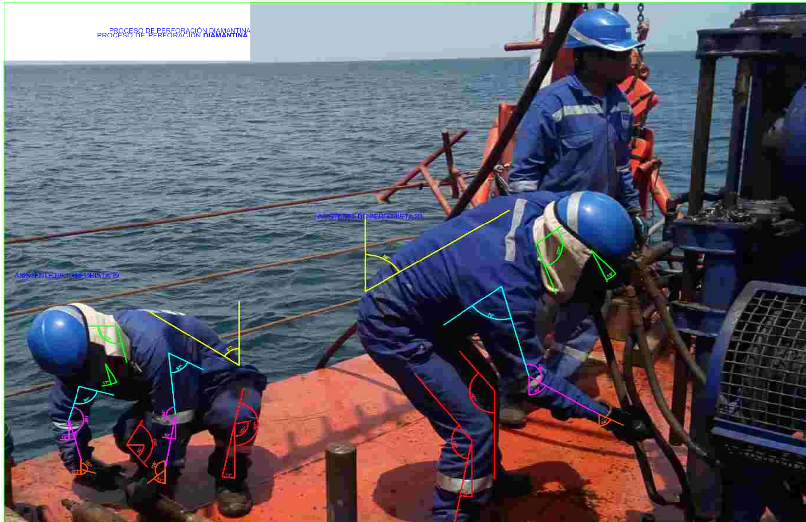
Figura 25. Proceso de Perforación. Ayudantes de Perforista 19 y 20 - Evaluados
