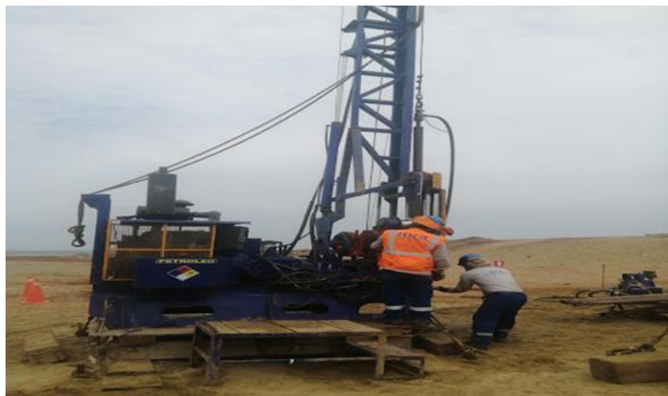
Figura 8. Máquina Perforadora con Sky.
