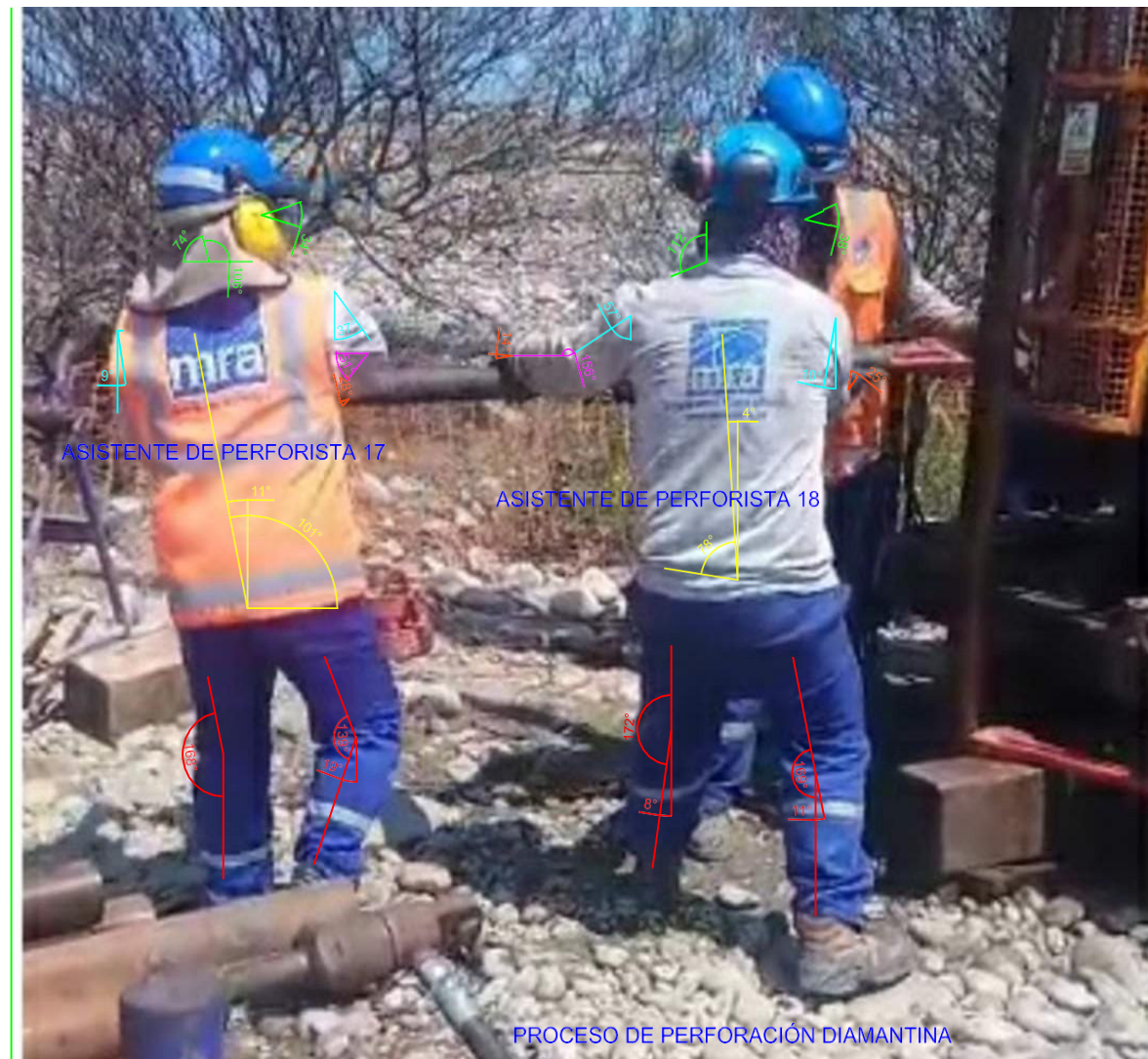
Figura 24. Proceso de Perforación. Ayudantes de Perforista 17 y 18 - Evaluados
