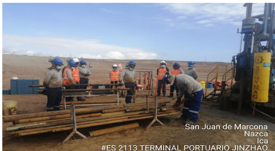
Figura 10. Plataforma de perforación
