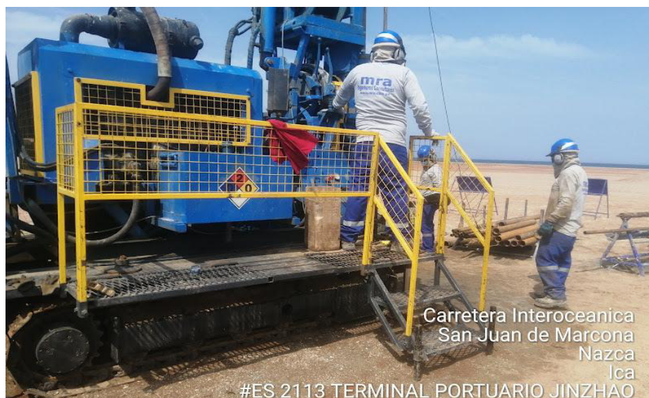
Figura 9. Máquina Perforadora con Sistema de Orugas
