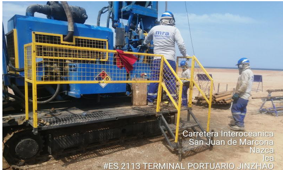
Figura 14. Implementación de Tarimas para Máquina Perforadora
