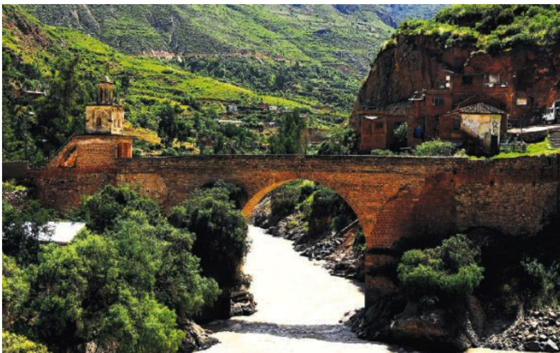
Figura 72. Puente de Izcuchaca, Huancavelica
