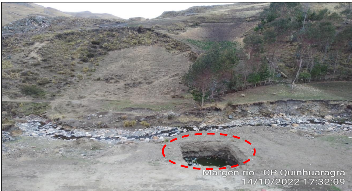
Tramo II – presencia de aguas residuales.
