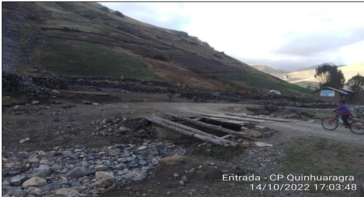
Puente ingreso al centro poblado Quinhuaragra
