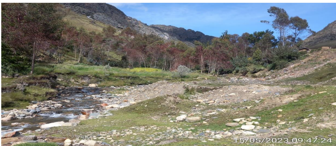
Tramo I centro poblado Quinhuaragra – febrero 2023
