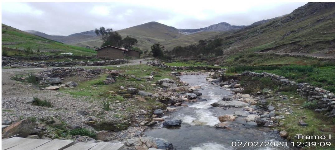
Tramo I centro poblado Quinhuaragra – febrero 2023
