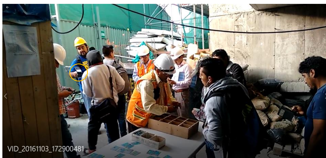
Figura 106. Salida de obra - Control de acceso con el dispositivo móvil. Fuente: Fotografías tomadas durante la ejecución del piloto. Elaboración propia.
