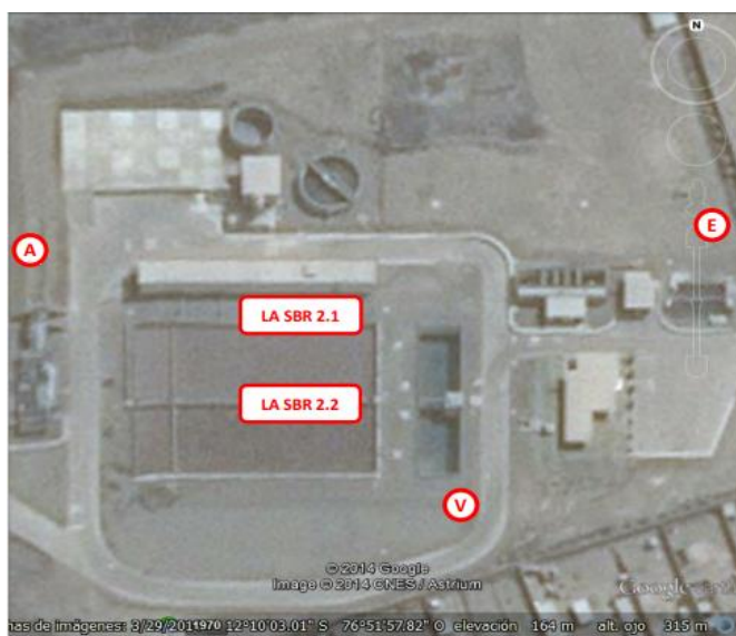
Figura 8: Vista superior de la PTAR Manchay
