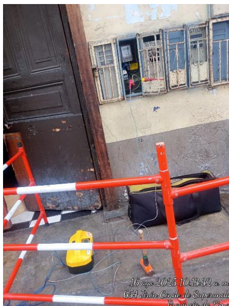
Figura 64. Uso de cable cocodrilo. Elaboración propia
