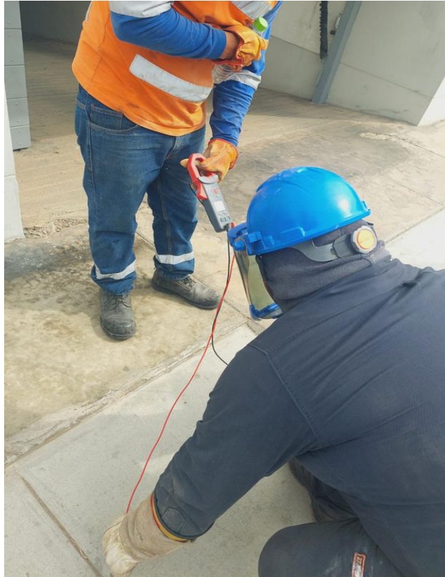
Figura 53. Medición de tensión de paso. Elaboración propia Apertura de zanja
