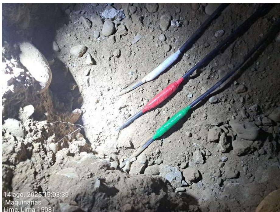
Figura 62. Cable reparado. Elaboración propia
