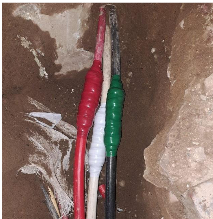
Figura 56. Reparación en red matriz. Elaboración propia Normalización de la zona
