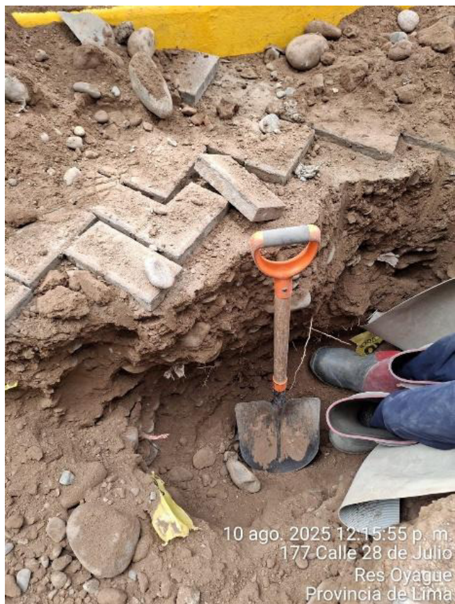
Figura 67. Apertura de zanja. Elaboración propia
