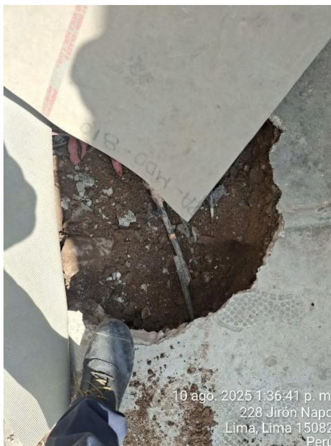
Figura 60. Apertura de zanja. Elaboración propia
