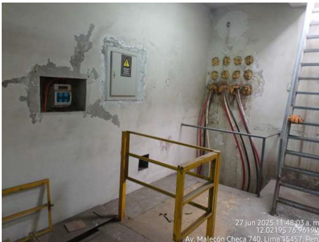
Figura 19. Subestación convencional subterránea. Elaboración propia
