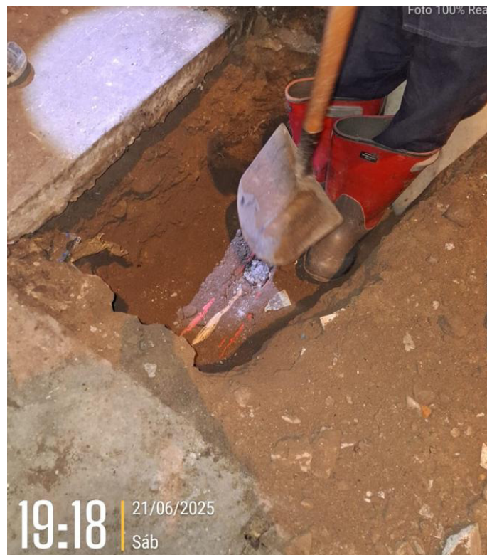
Figura 54. Apertura de zanja. Elaboración propia Falla ubicada
