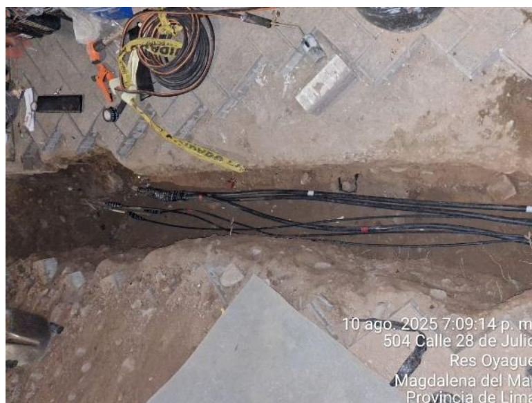
Figura 69. Cable reparado. Elaboración propia
