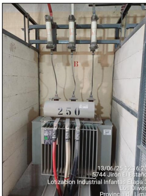
Figura 23. Transformador de distribución ABB. Elaboración propia
