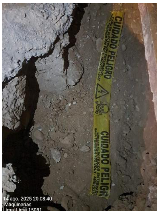
Figura 63. Cierre de zanja. Elaboración propia
