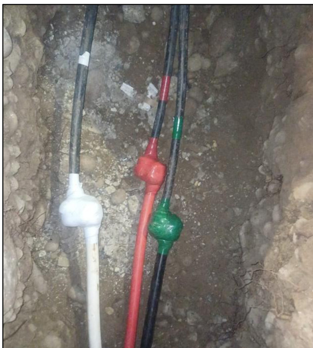
Figura 29. Empalme simétrico. Elaboración propia
