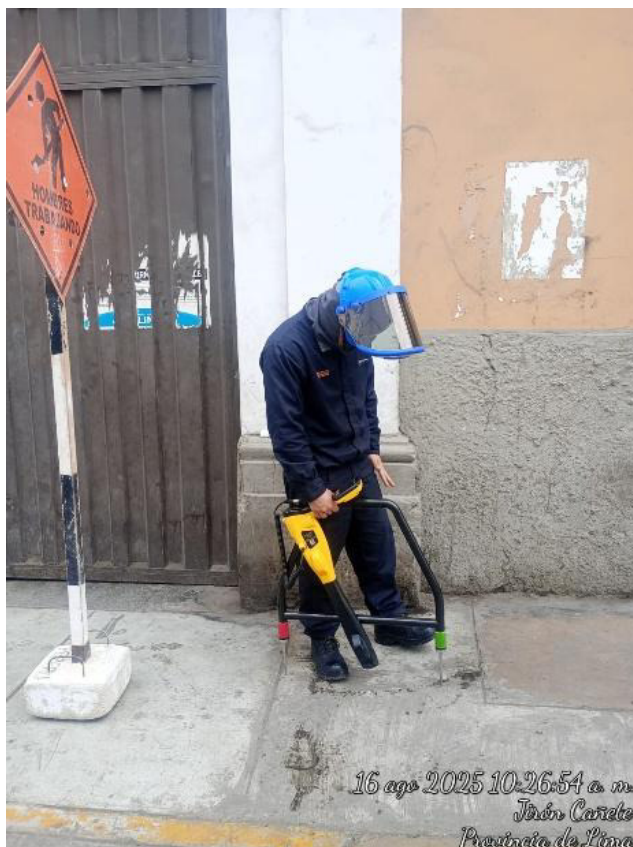
Figura 65. Uso de bastón y arco. Elaboración propia
