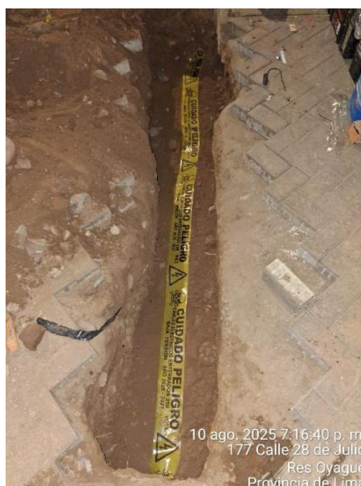
Figura 70. Cierre de zanja y zona con servicio. Elaboración propia
